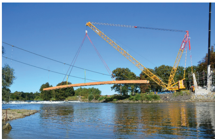
Slika 9. Montaža nosilnih vrvi.
