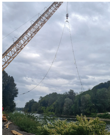
Slika 9. Montaža nosilnih vrvi.
