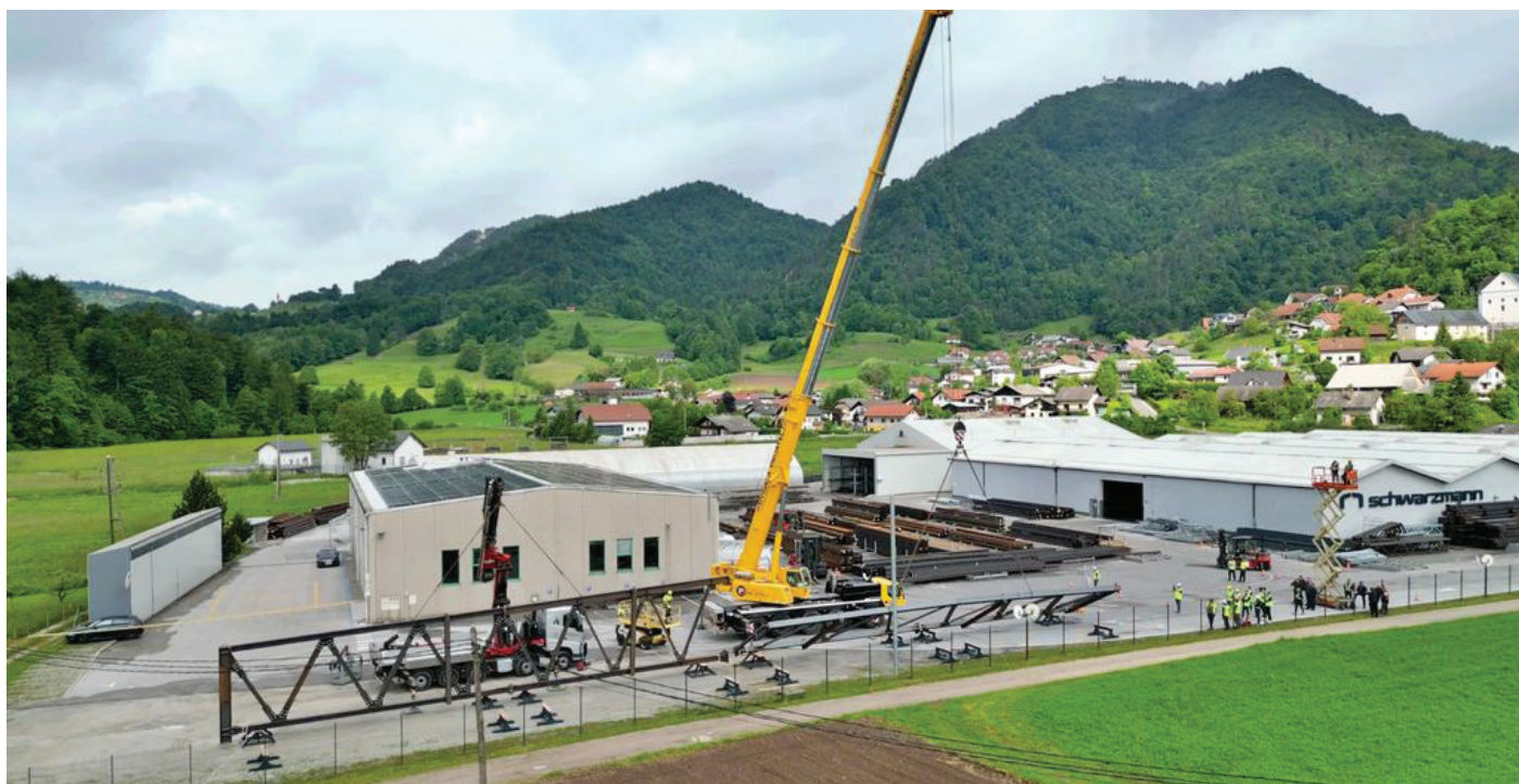
Slika 12. Testni dvig nosilca (foto: arhiv Schwarzmann).
