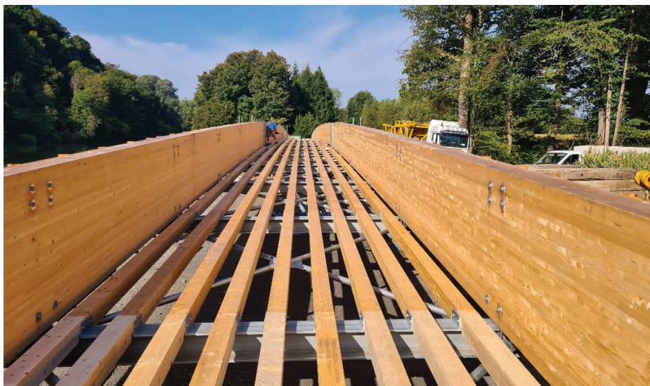
Slika 8. Montaža jeklenih prečnikov, vzdolžnikov in zunanjih opažev.
