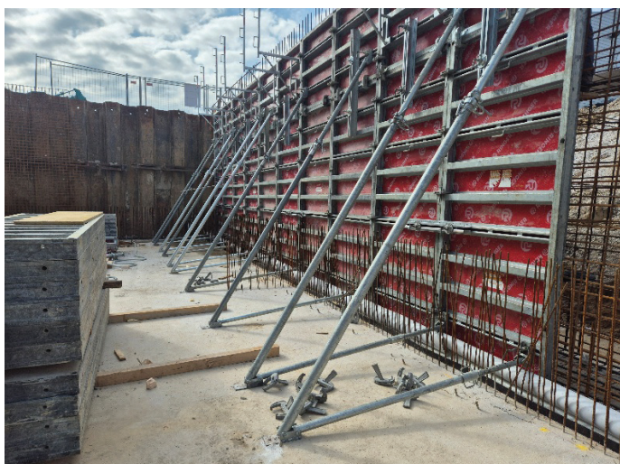
Slika 3. Opaž pasovnega temelja (foto: P. G. Volk).
