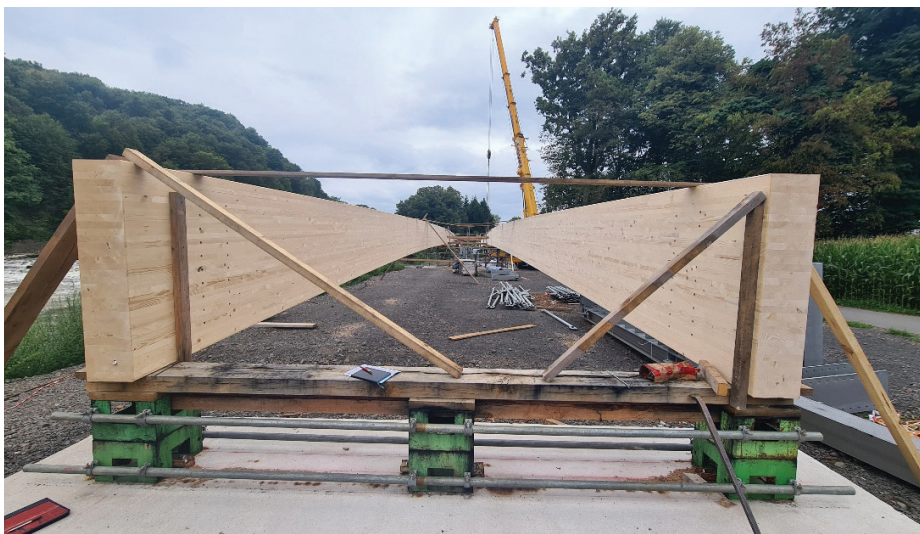
Slika 7. ... montaža lesenih nosilcev na gradbišču (avgust 2025).
