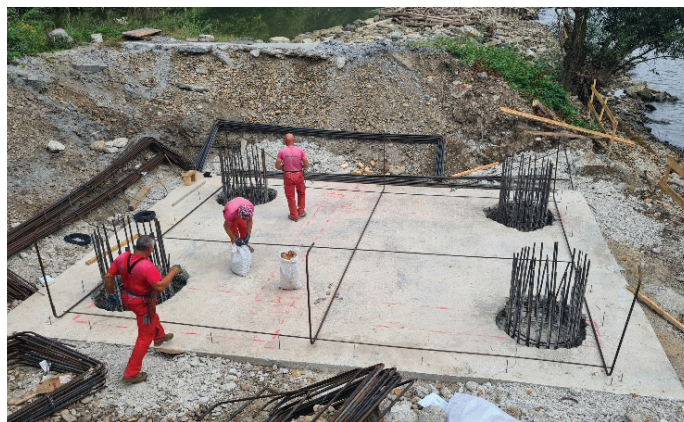
Slika 4. Začetek polaganja armature temeljne plošče.
