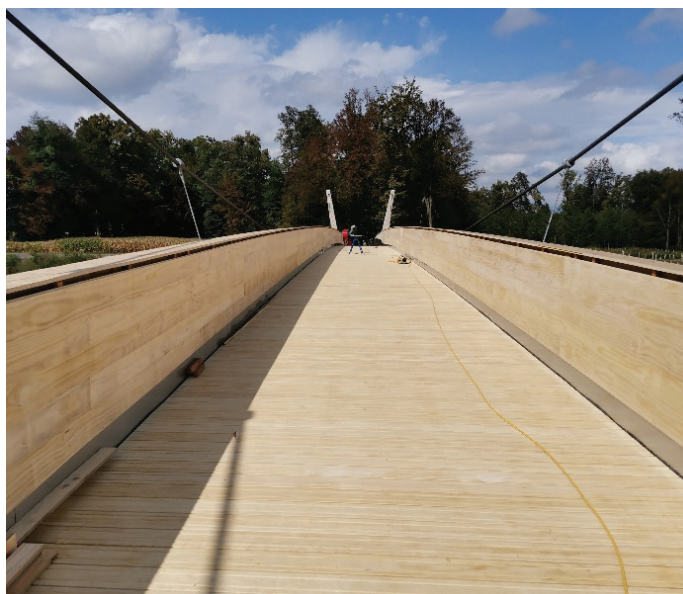
Sliki 20, 21. Montaža krovne konstrukcije, notranjih opažev in mostne opreme (september 2025).
