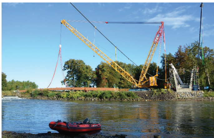
Slika 8. Montaža jeklenih prečnikov, vzdolžnikov in zunanjih opažev.
