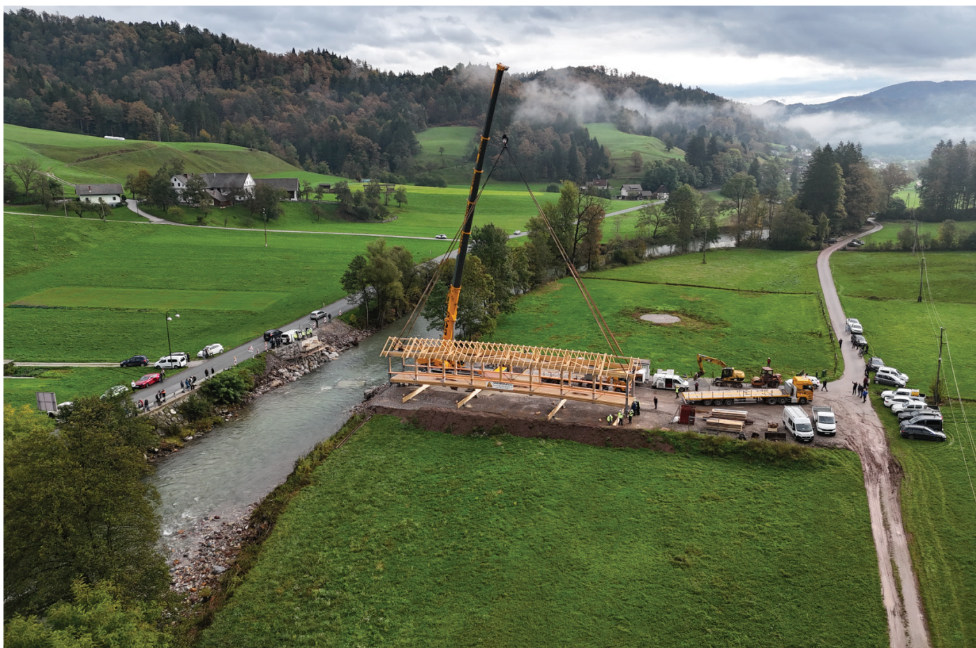
Slika 7. Nosilna konstrukcija med dvigom, oktober 2024.
