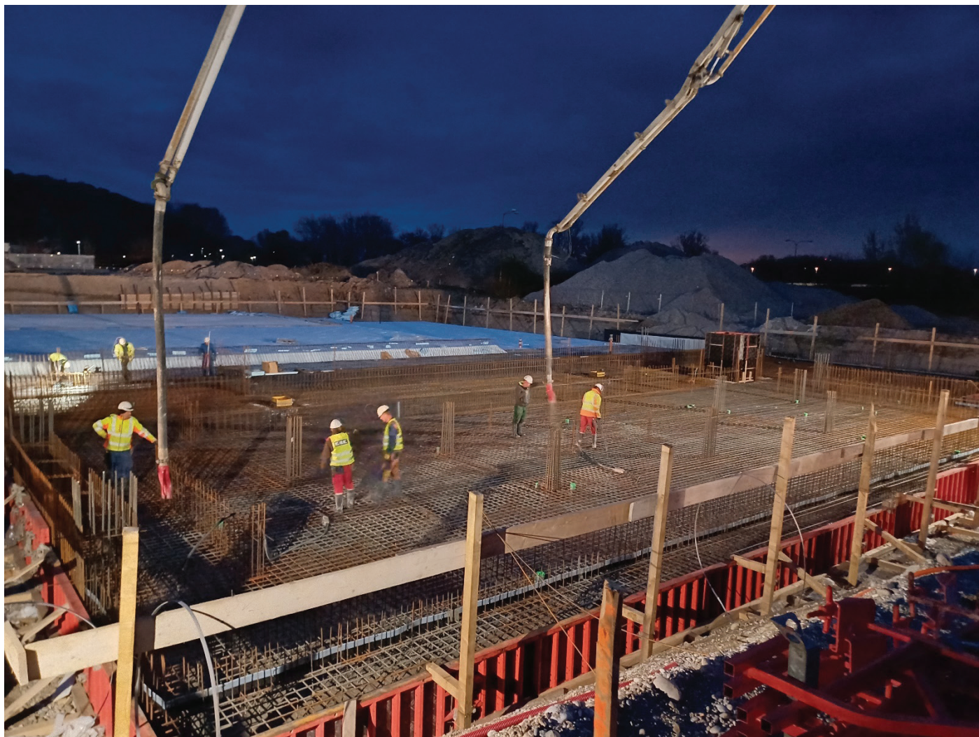
Slika 3. Nočna betonaža.
