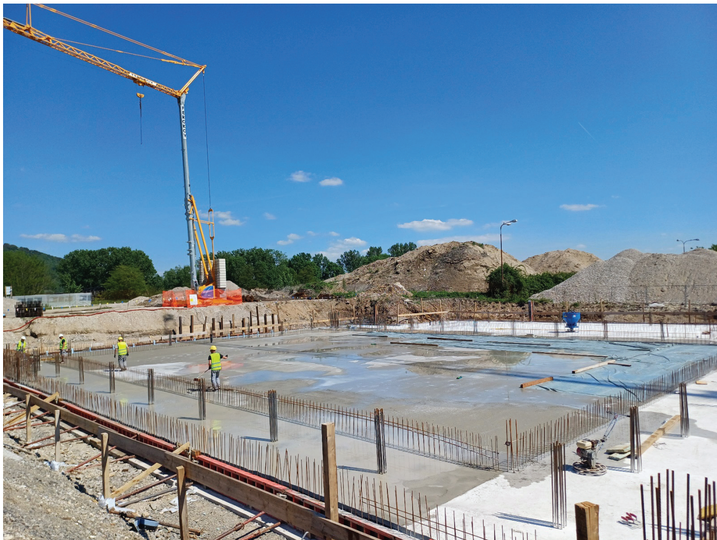
Slika 4. Nega betona.
