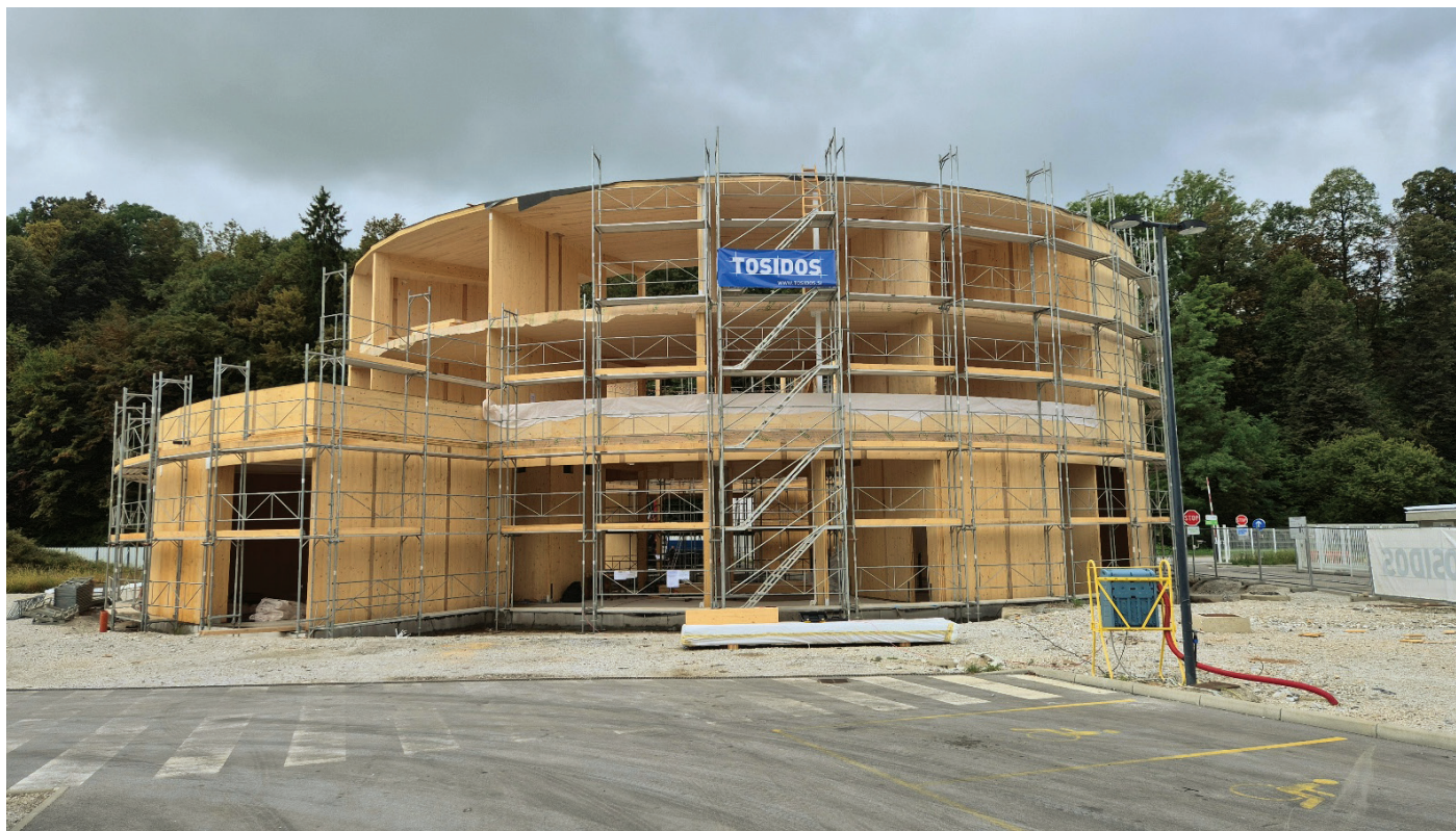
Slika 1. Zaključena nosilna konstrukcija Centra krožnega gospodarstva Zarica (3. 9. 2025). Foto: Mitja Lalović.
