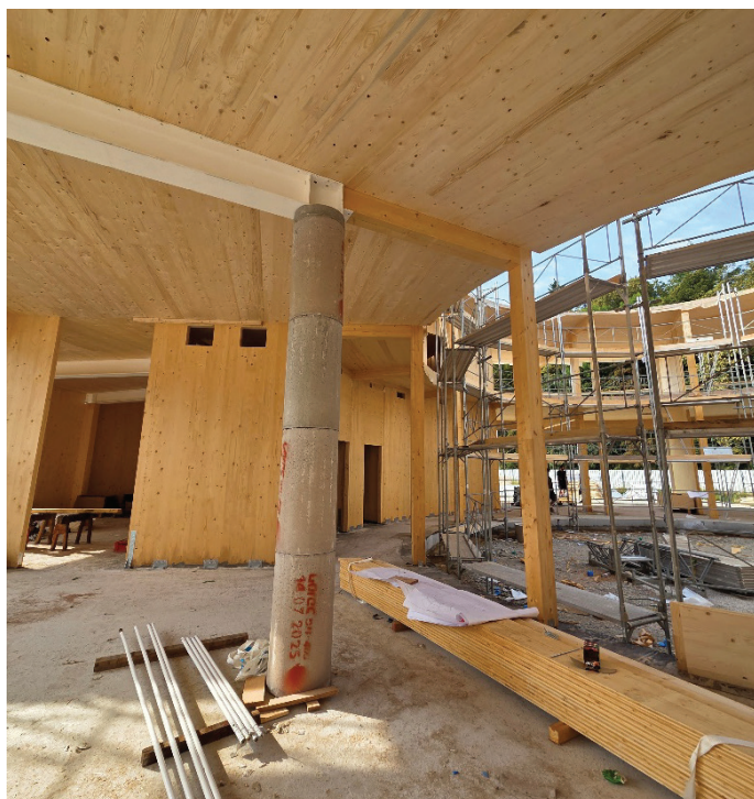
Slika 8. Kombinacija les-jeklo-beton. Foto: Katarina Sirk.
