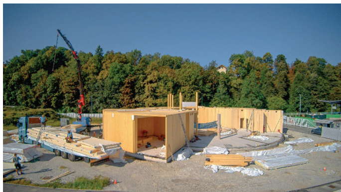
Slika 3. Gradnja pritlične etaže (19. 8. 2025). Foto: Nejc Vurnik.
