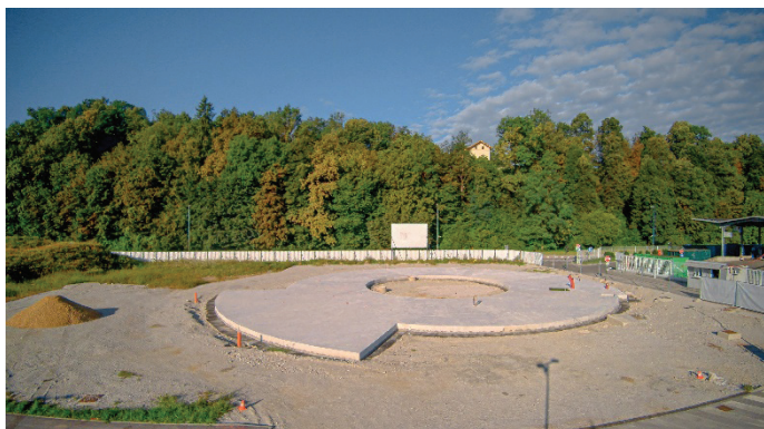
Slika 2. Temeljna plošča (5. 8. 2025). Foto: Nejc Vurnik.
