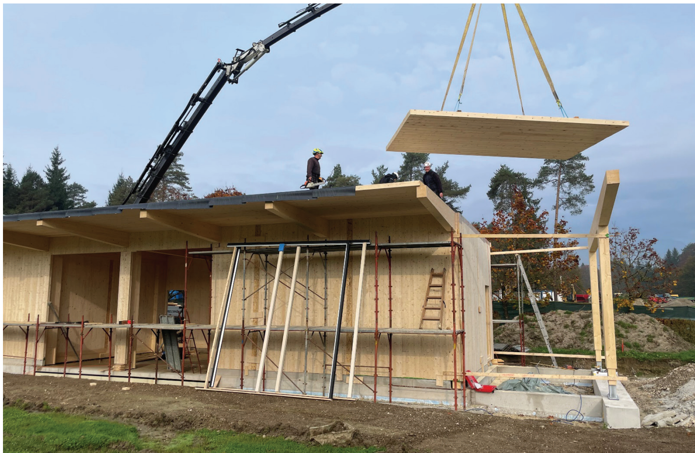
Slika 1. Montaža lesene konstrukcije iQwood, ki je bile izdelane v proizvodnji v Topolah pri Mengšu.
