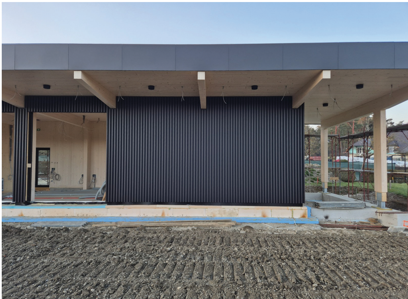
Slika 8. Izvedba prezračevane ALU-fasade in čelne ALU-obloge.
