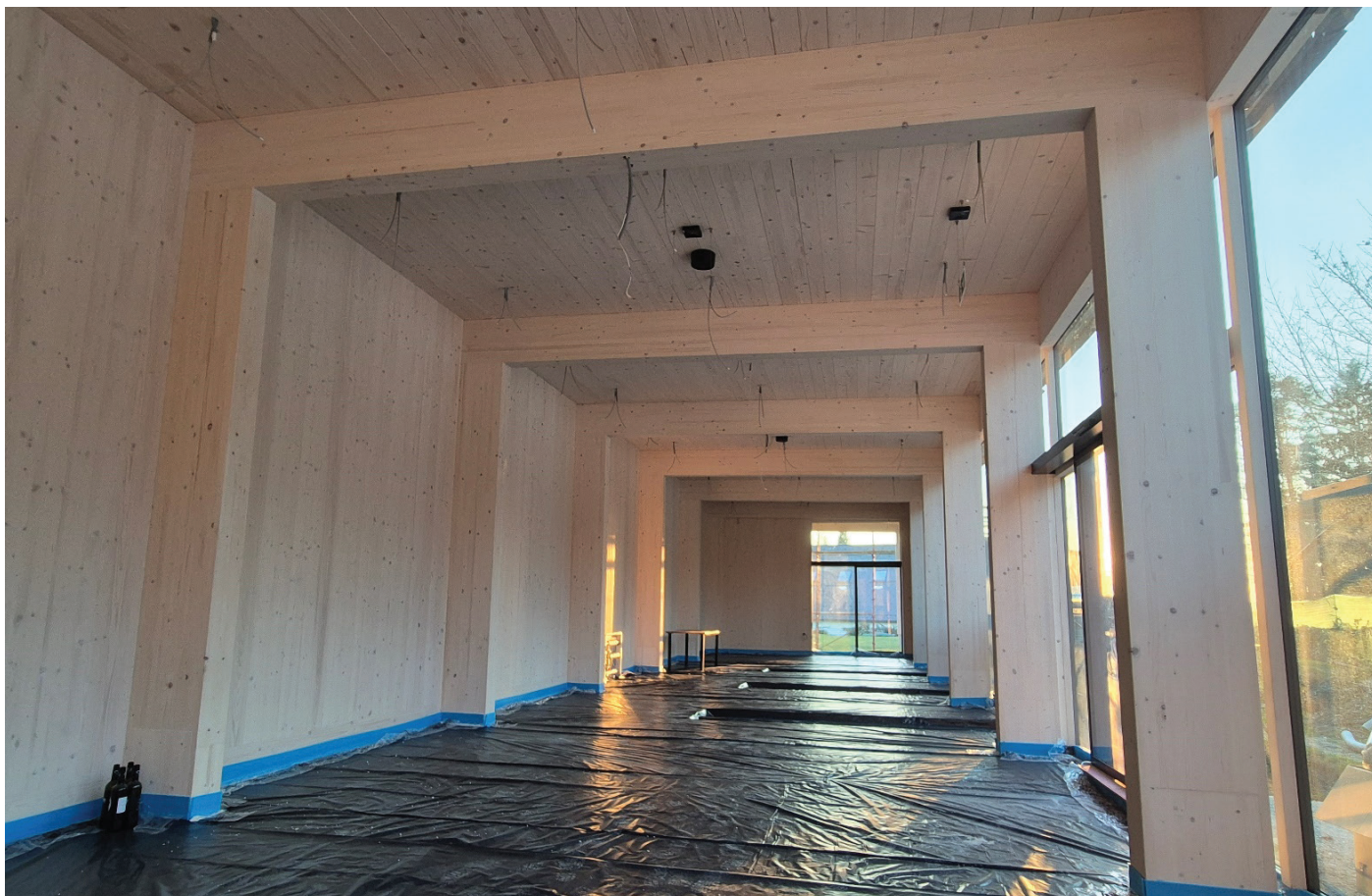
Slika 11. Notranjost trgovinskega objekta, pripravljena za izvedbo estriha.
