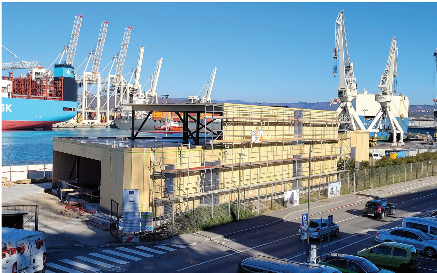
Slika 1. Lesena konstrukcija z integriranimi jeklenimi elementi objekta potniški terminal Luke Koper je bila od sredine decembra 2024 do konca januarja 2025 sestavljena v 20 delovnih dneh (foto: arhiv CBD, d. o. o.).
