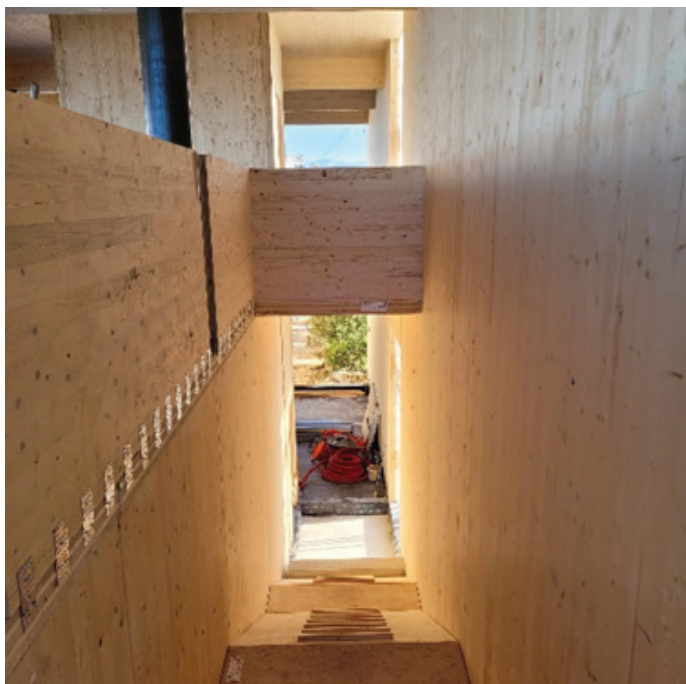
Slika 10. Prikaz sestave hibridne leseno-jeklene konstrukcije.
