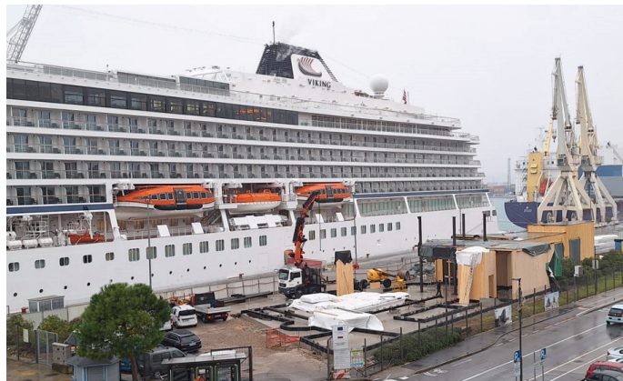
Slika 3. Pogled na delovišče v času prisotnosti križarke, ki s svojo veličino razbline višino prve etaže objekta, ki je visoka okoli 5 m, skupna višina objekta pa skoraj 9 m.
