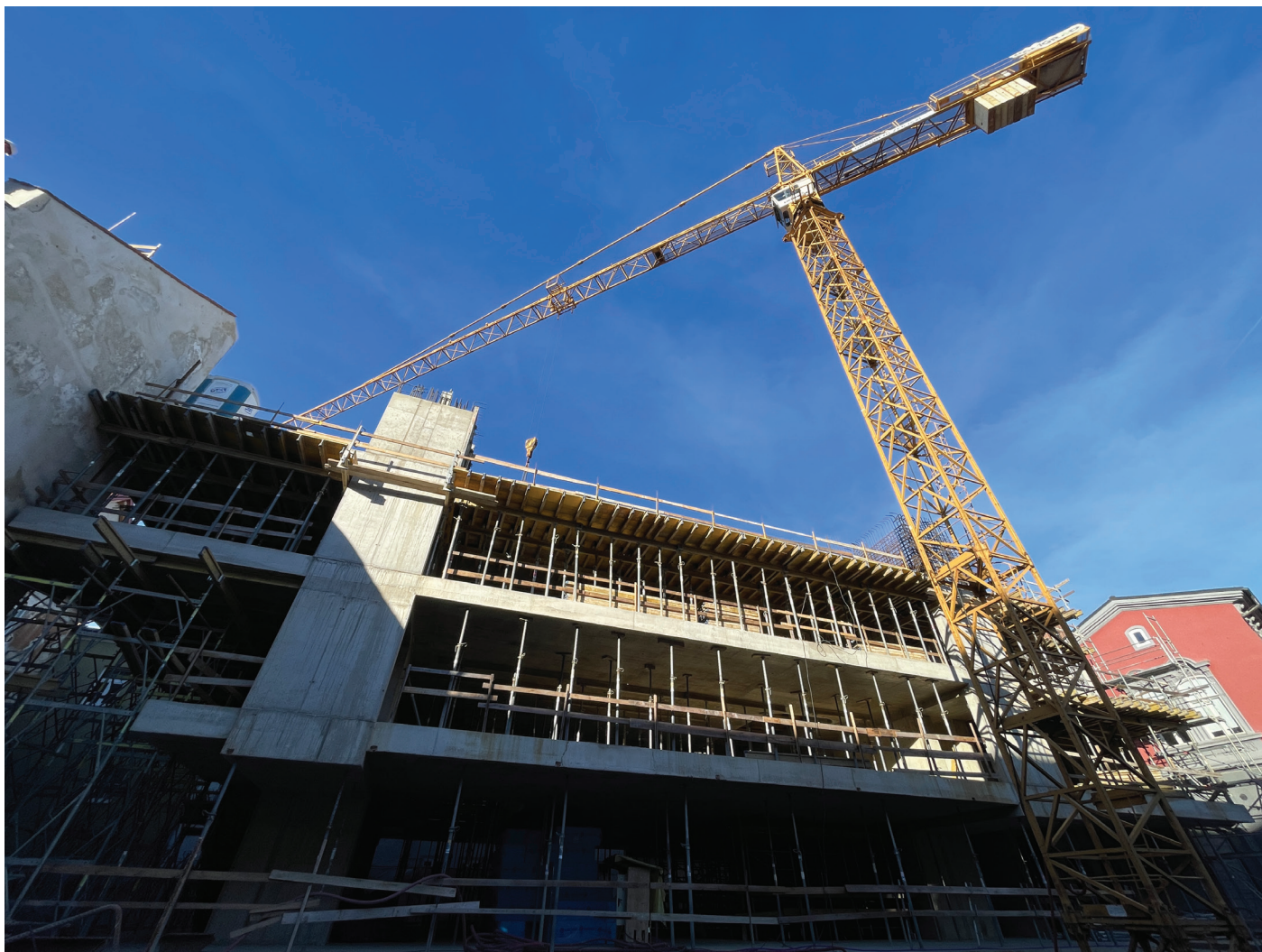
Slika 2. Gradbena dela na novi Mariborski knjižnici (25. 11. 2024).
