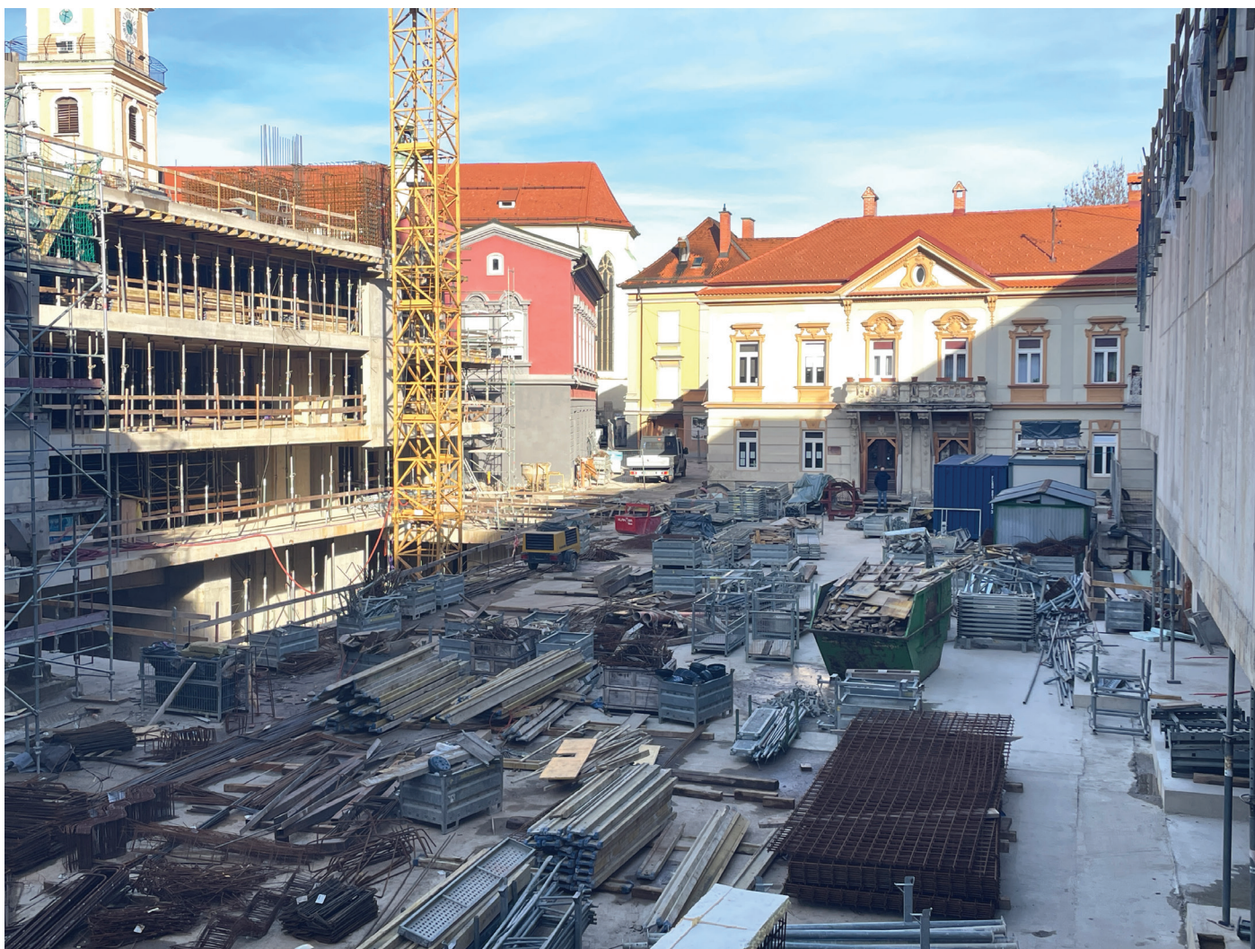
Slika 1. Pogled na gradbišče Centra Rotovž (25. 11. 2024).
