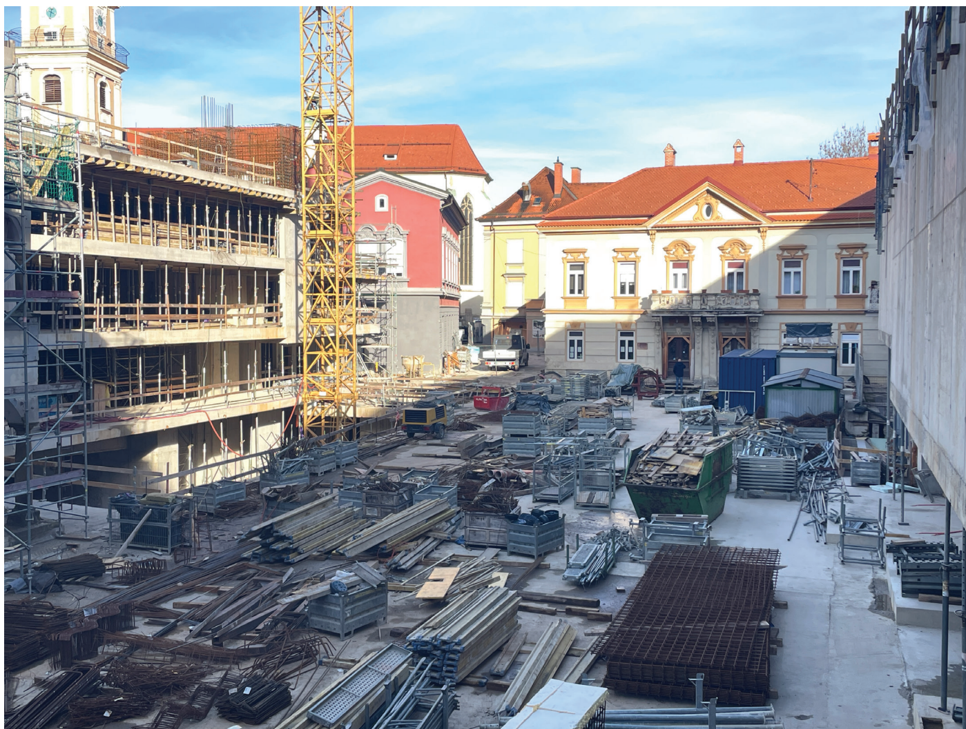
Slika 1. Pogled na gradbišče Centra Rotovž (25. 11. 2024).
