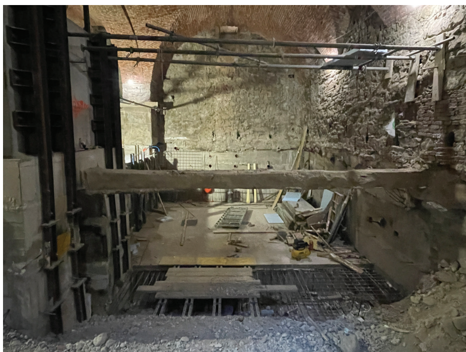
Slika 6. Pogled na gradnjo Art Kina Rotovž (25. 11. 2024).
