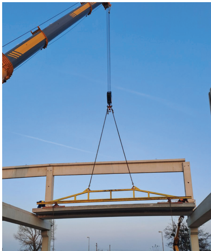
Slika 9. Montaža prednapetih votlih plošč z dviznimi klešči.
