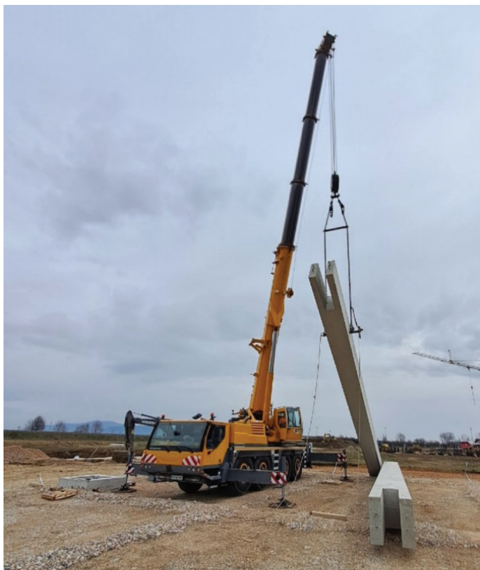
Slika 2. Dvig stebra iz horizontalnega v vertikalni položaj s pomočjo specializiranih orodij.
