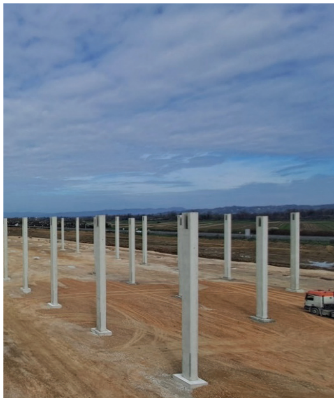
Slika 3. Delno postavljeni prefabricirani AB-stebri.
