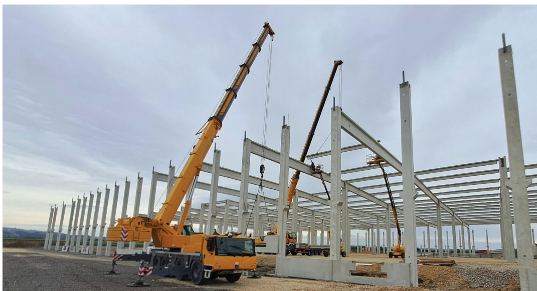
Slika 10. Na gradbišču smo na koncu objekta imeli dve ekipi, prva je montirala strešno konstrukcijo in druga montažne parapete.
