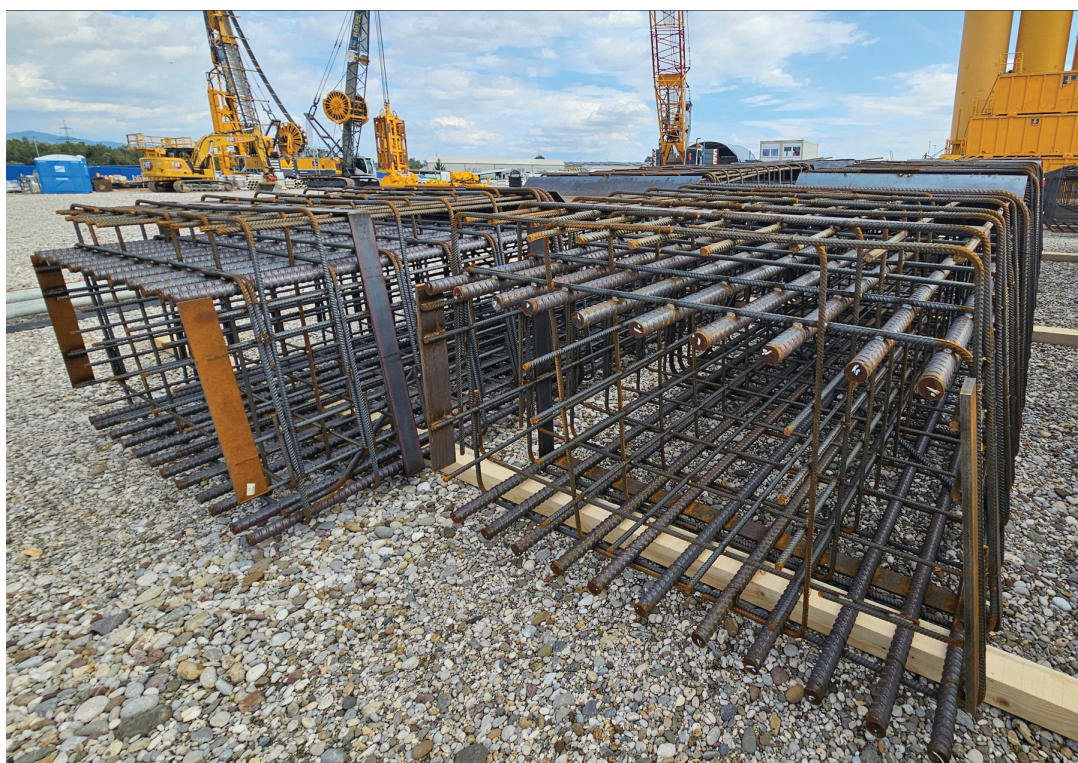
Slika 2. Segmenti armaturnega koša primarnega panela (mdr. nosilne palice Ø50 mm).
