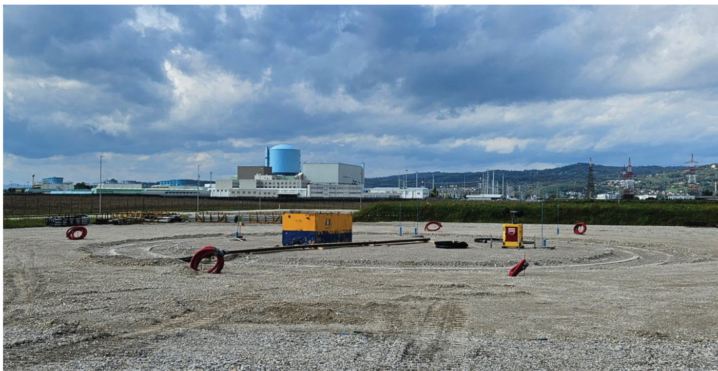
Slika 1. Lokacija odlagalnega silosa. Zadaj Nuklearna elektrarna Krško (NEK). Na sliki je vidna izvedena krožna uvodnica za izkop diafragme.
