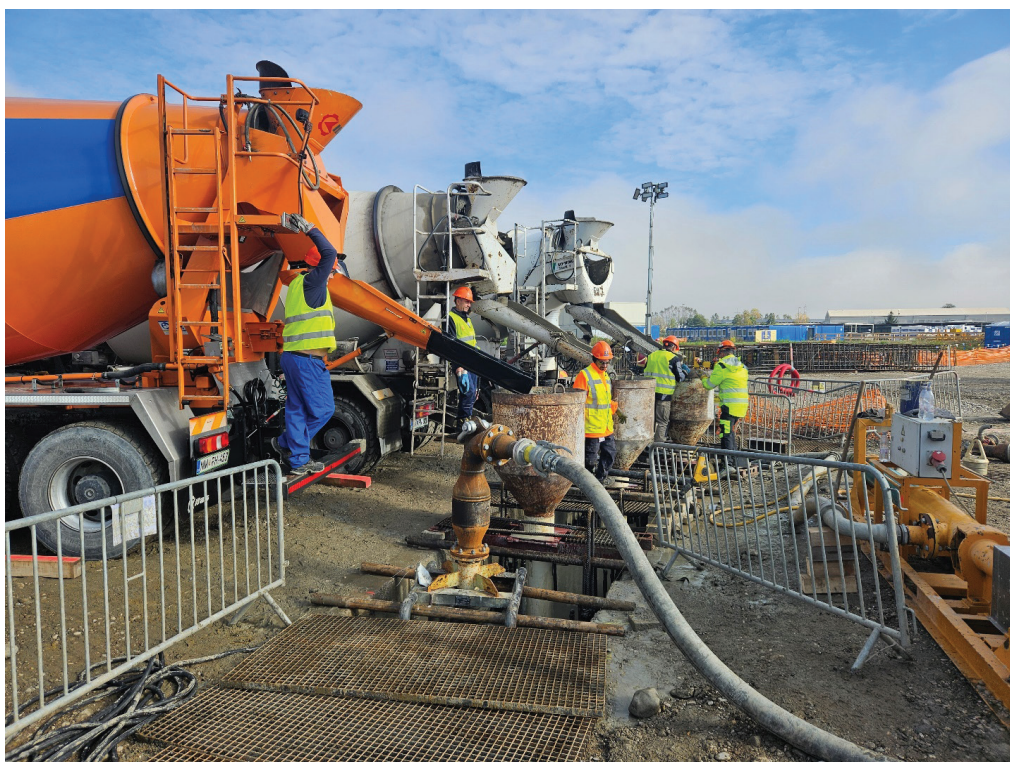
Slika 7. Kontraktorsko betoniranje primarnega panela.
