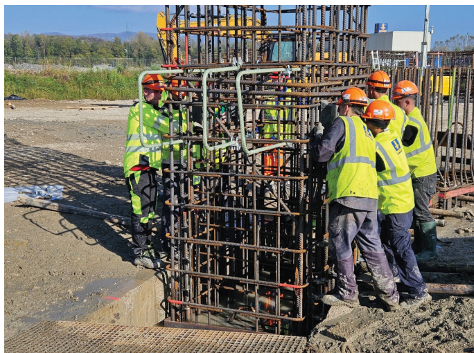
Slika 6. Stikovanje armaturnih košev.
