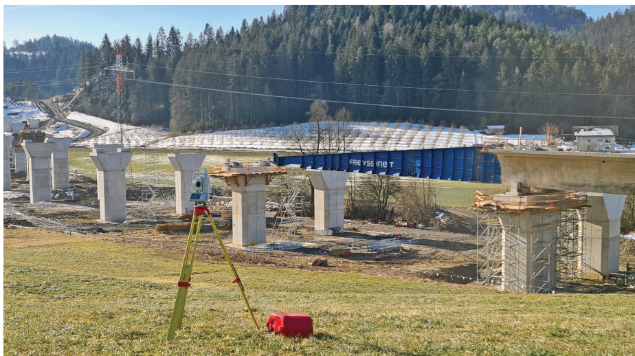
Slika 7. Pogled na desni viadukt in kljun za narivanje proti oporniku 1.
