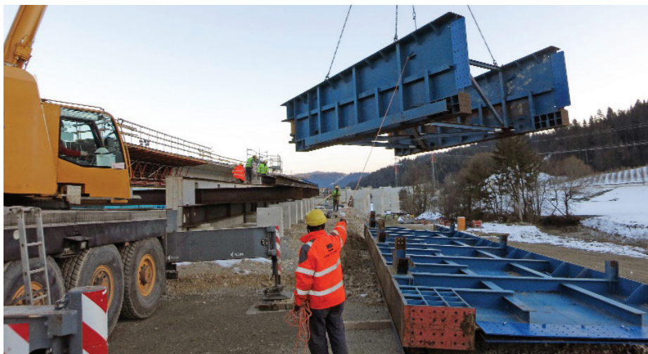
Slika 1. Montaža levega kljuna za narivanje na delavnico za narivanje.
