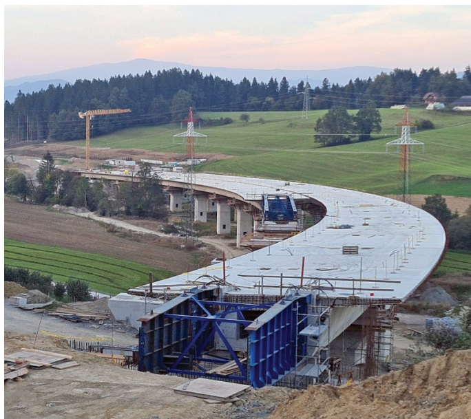
Slika 10. Narivanje zadnjega, 25. takta desnega objekta s sočasno demontažo kljuna za narivanje.
