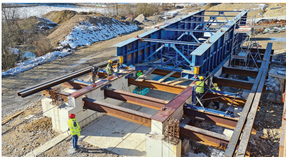
Slika 2. Narivanje levega kljuna na izhodiščni položaj – montaža na izhodiščni položaj za izgradnjo prvega segmenta ni bila mogoča, zato se je kljun narinil iz delavnice za narivanje preko opornika.
