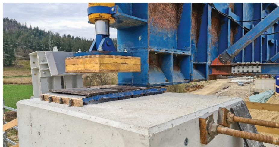
**Slika 4.** Prvi prehod levega kljuna na steber – vidni osnovni elementi narivanja: začasno drsno ležišče, teflonske drsne plošče, bočno vodilo, kljun za narivanje z dvižnimi bati za dvig povešene konzole na steber.
