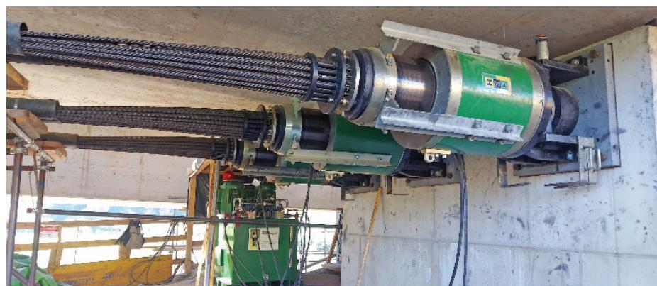
**Slika 5.** Narivni hidravlični bati za vlečenje s kabli za prednapenjanje –  $3 \times$  Hebetec H400 kapacitete  $3 \times 400$  ton,  $3 \times 37$  vrvi za prednapenjanje. Med gradnjo se postopoma menjajo vlečne palice Freyssibar z najprej dvema, nato pa s tremi t. i. »strand jacki«.
