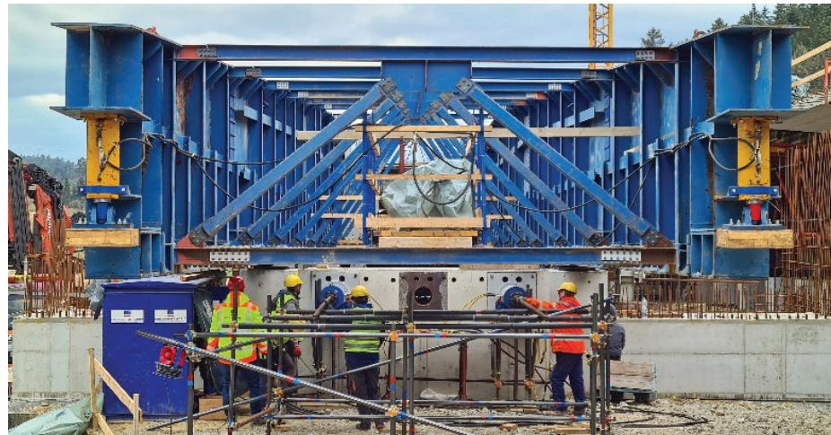
**Slika 3.** Narivanje 1. taka levega objekta – začetna narivanja z dvema votlima batoma kapacitete  $2 \times 150$  t z vlečnima navojnima palicama Freyssibar B50.
