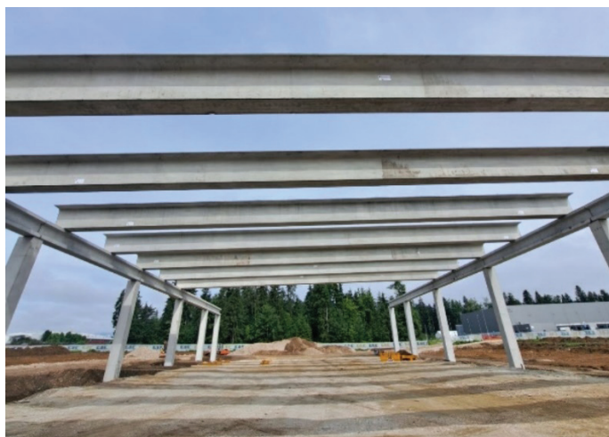
Slika 7. Glavna nosilna konstrukcija skladiščnega dela objekta.
