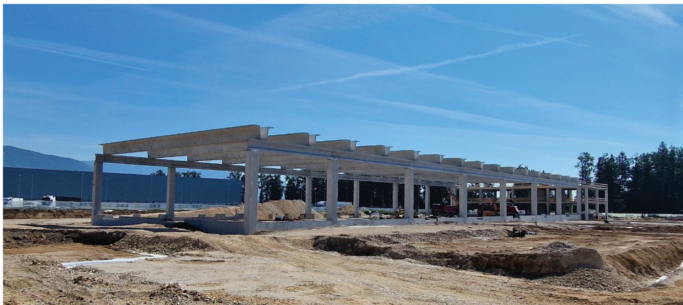
Slika 9. Zaključena gradnja montažne konstrukcije skladišča in upravnega dela objekta (avgust, 2024).
