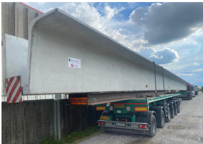
Slika 4. Prednapeti »wing« nosilec, pripravljen za izredni prevoz.
