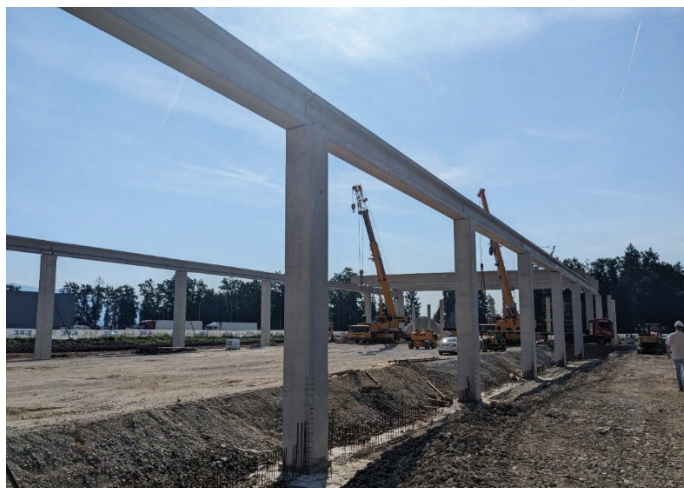
Slika 5. Postavitev stebrov in »wing« nosilcev.
