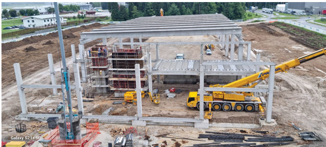
Slika 8. Montaža nosilne konstrukcije upravnega dela objekta.
