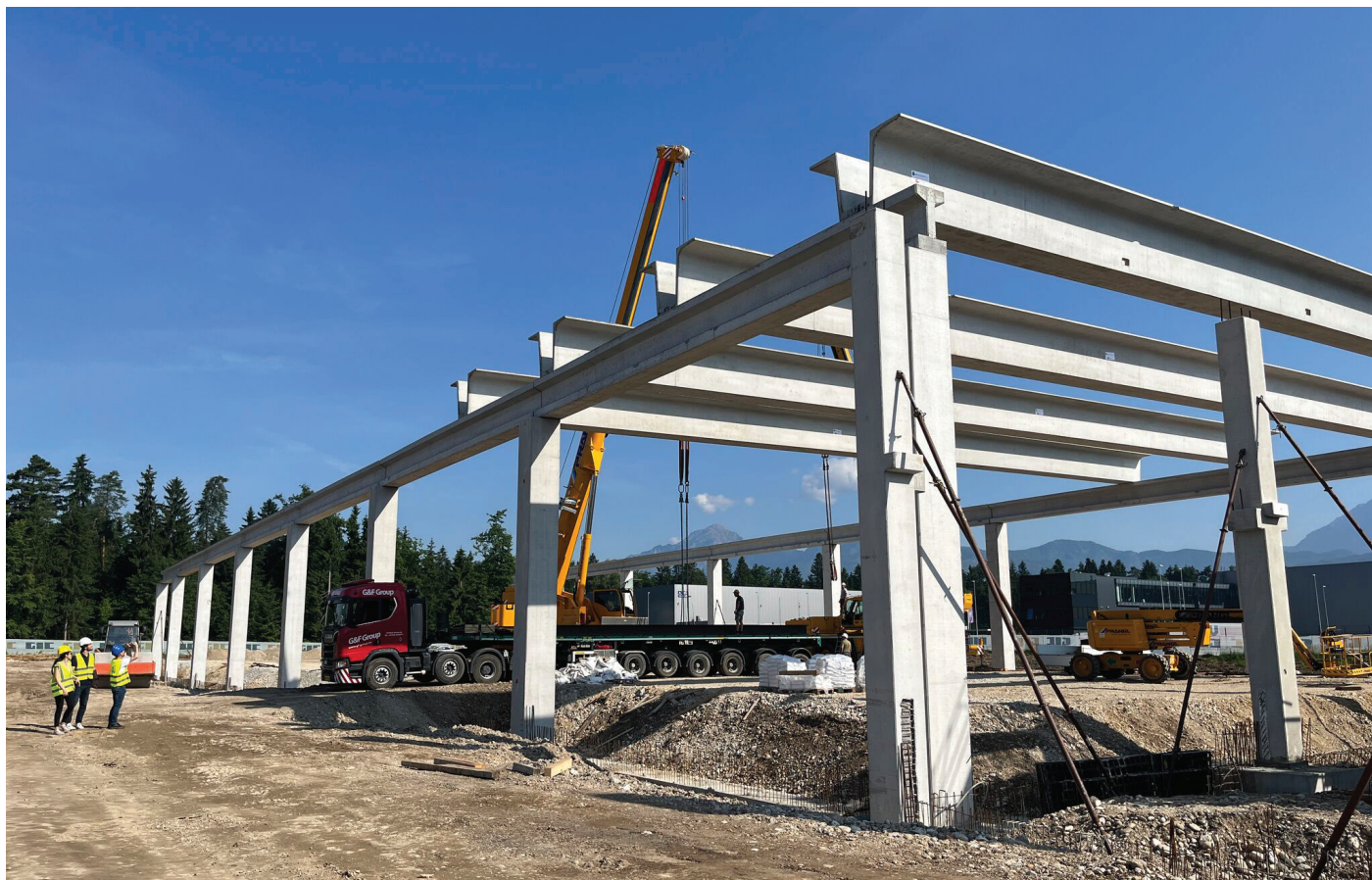
Slika 1. Montažna AB-konstrukcija logističnega centa DHL na Brniku.
