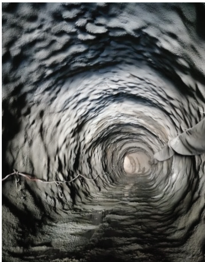
Slika 23. Gradnja predora – primarna podgradnja.
