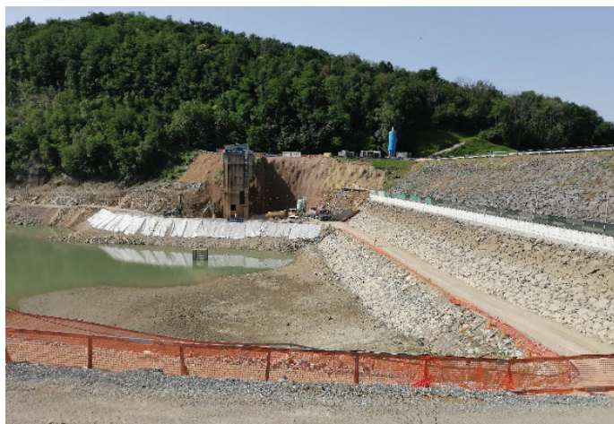
Slika 6. Zaščita gradbene jame.
