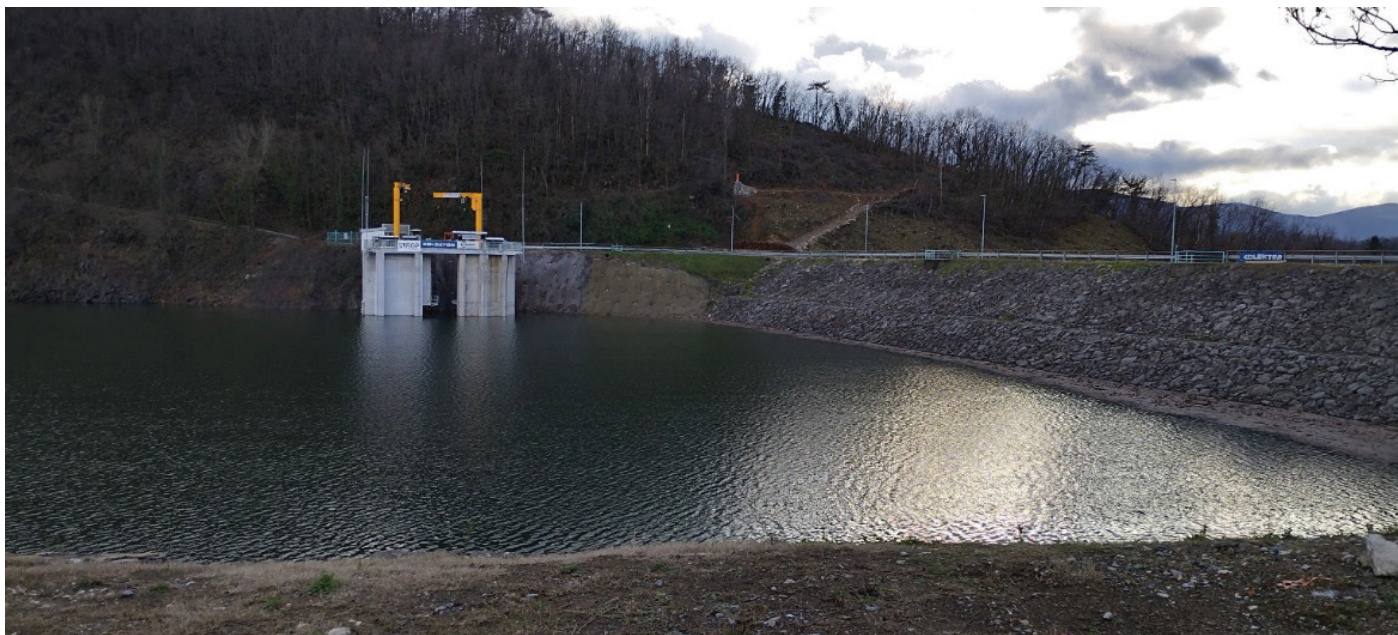
Slika 29. Vodna stran po zaključku del.
