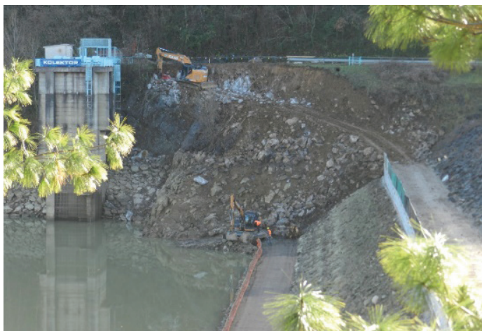
Slika 5. Gradbena jama za odzemni objekt – začetno stanje.
