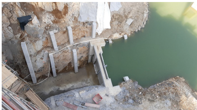
Slika 19. Gradnja dovodnega jarka – konstrukcija z montažno bariero.
