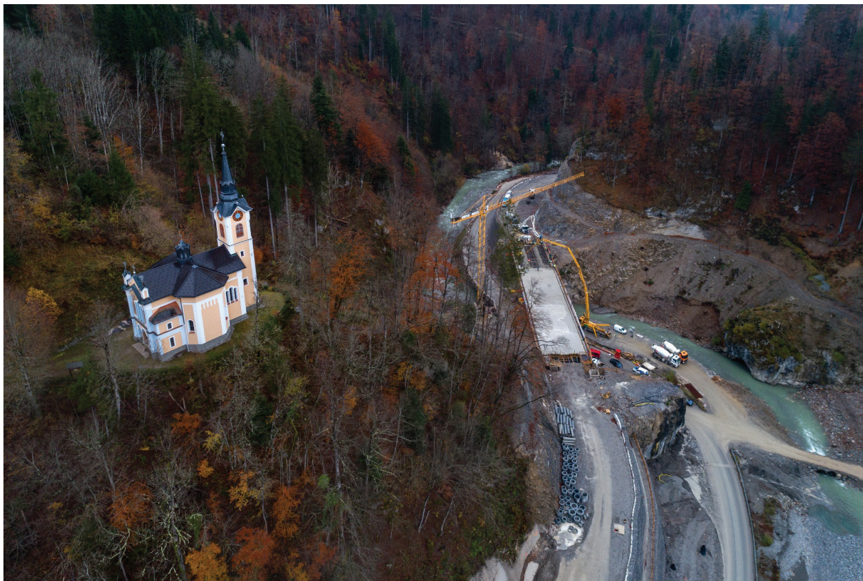
Slika 1. Betoniranje mostu čez Selško Soro (Foto: Andrej Tarfila).
