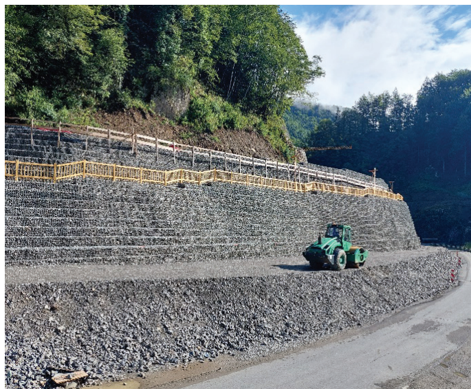
Sliki 16 in 17. Gradnja gabionskega zidu, nad katerim bo potekala prestavljena regionalna cesta (Foto: Karolina Korenčan).
