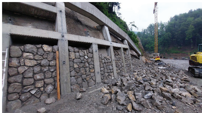
Slika 20. AB-slopi in pozidava (Foto: Ivan Marušič).
