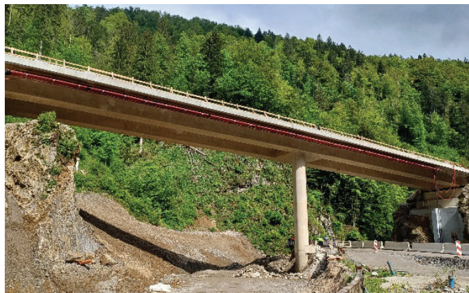
Slika 15. Pogled na most (Foto: Amir Pjanić).
