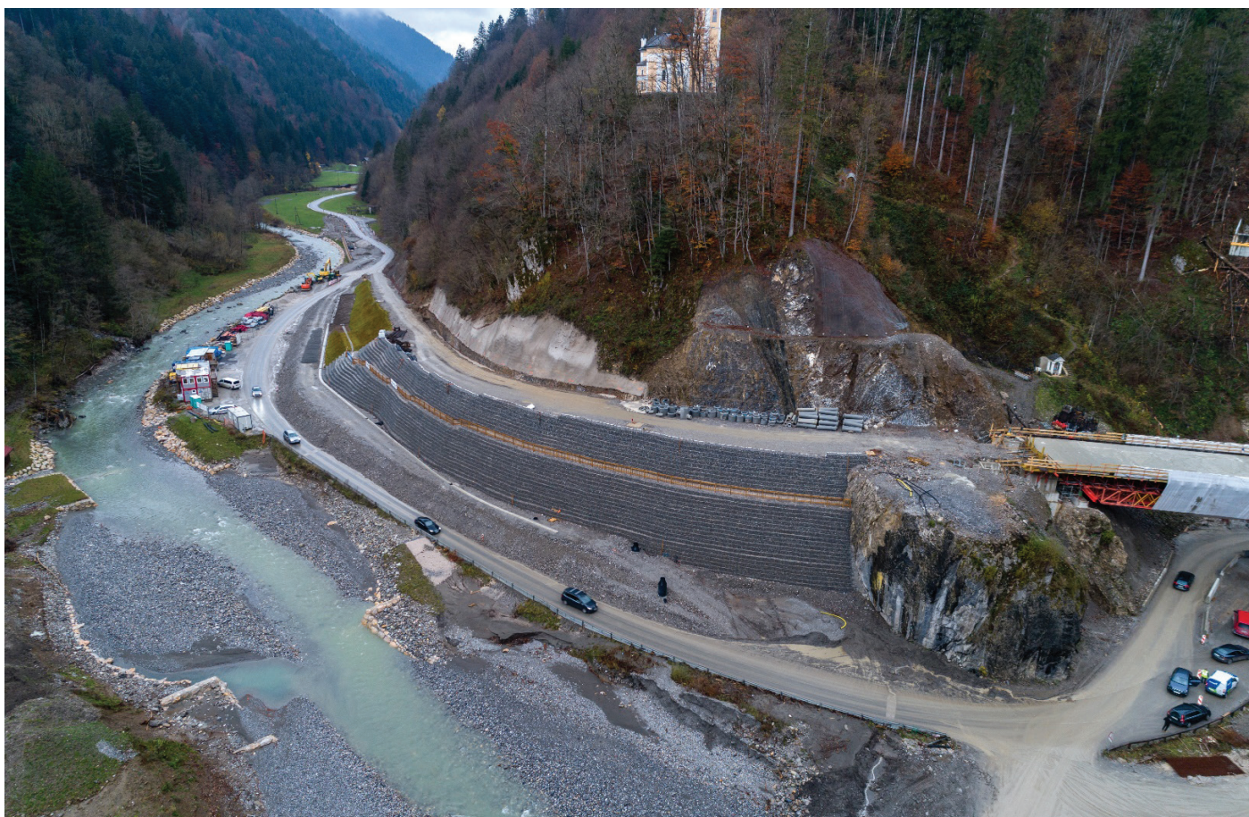
Slika 18. Prestavitev regionalne ceste, vrezane v strmo skalno pobočje (Foto: Andrej Tarfila).
