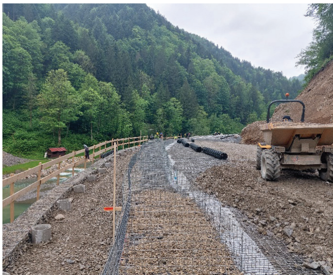
Sliki 16 in 17. Gradnja gabionskega zidu, nad katerim bo potekala prestavljena regionalna cesta (Foto: Karolina Korenčan).
