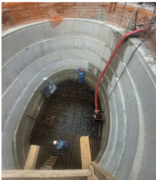
Sliki 9 in 10. Gradnja vmesnega opornika v vodnjaku (Foto: Karolina Korenčan).
