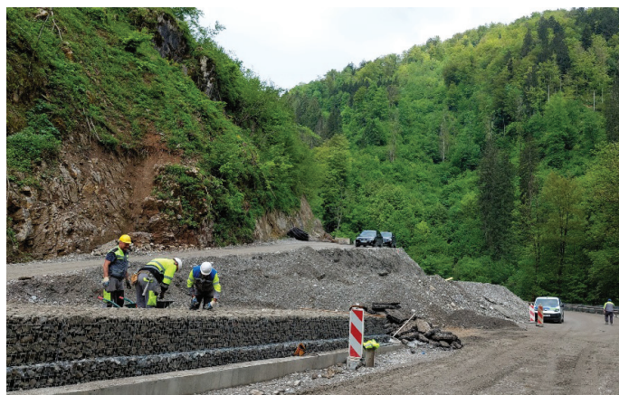
Slika 8. Gradnja gabionskega zidu (Foto: Karolina Korenčan).
