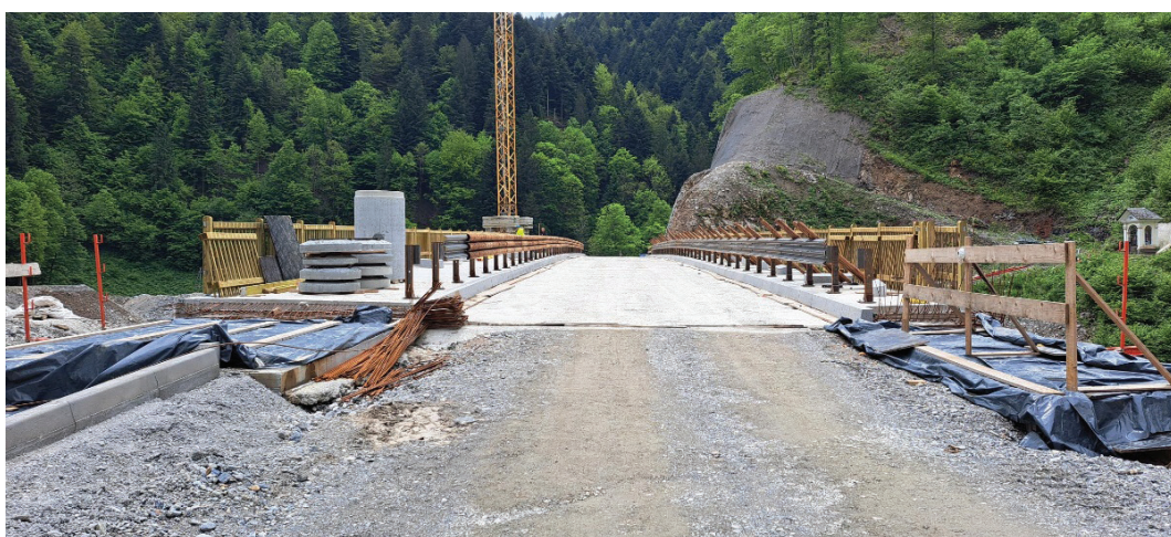
Slika 21. Pogled na most (Foto: Ivan Marušič).
