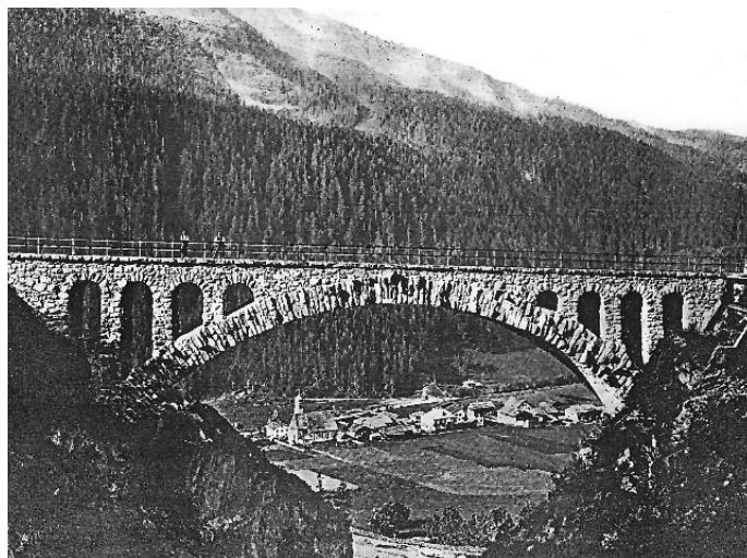
Slika 10. Kamniti most Wäldlitobel na avstrijskem tirolskem z razponom loka 41 m. Zgrajen je bil leta 1884 pri kraju Klösterle (povzeto iz knjige Grandes voûtes , Tome II, str. 157, avtorja P. Séjournéja [Séjourné, 1913–1916]).
