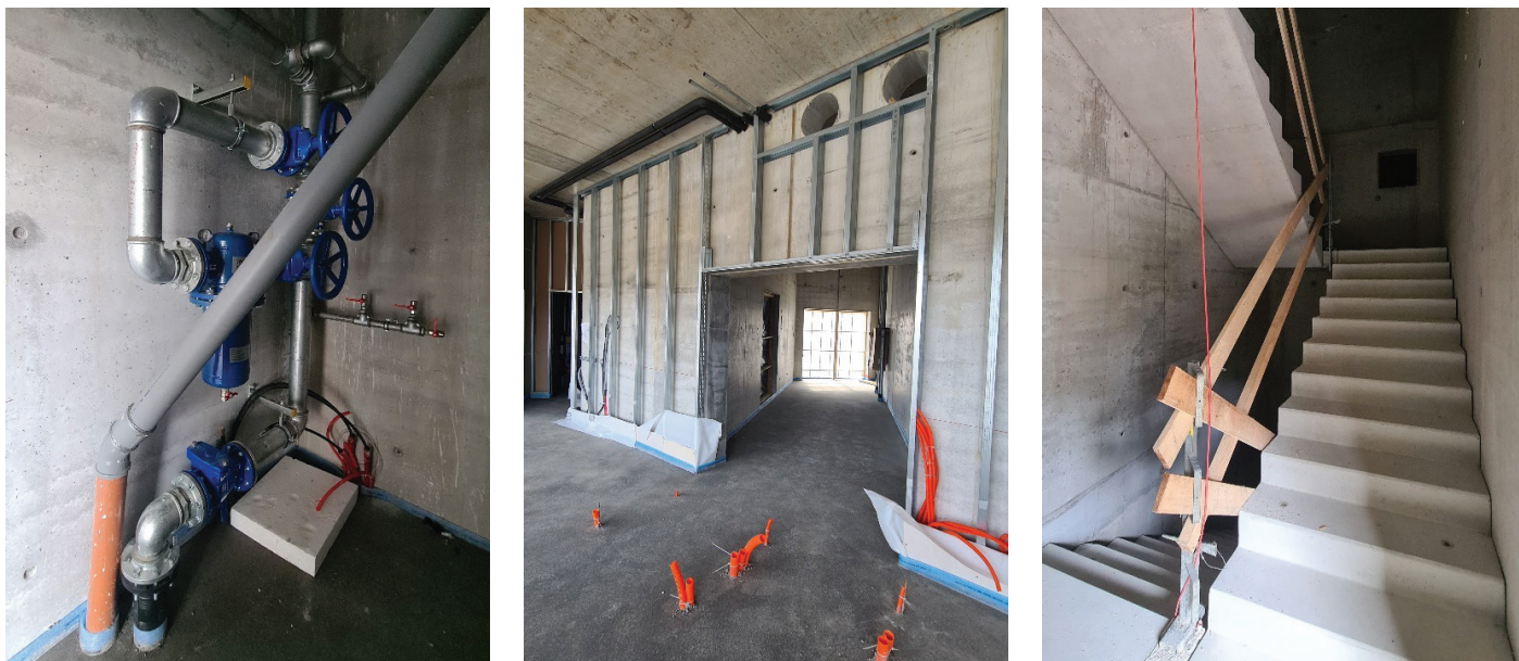
Slike 11, 12, 13. Istočasno že poteka tudi vgradnja tlakov, strojnih/elektro inštalacij ter montaža varnostnega stopnišča.
