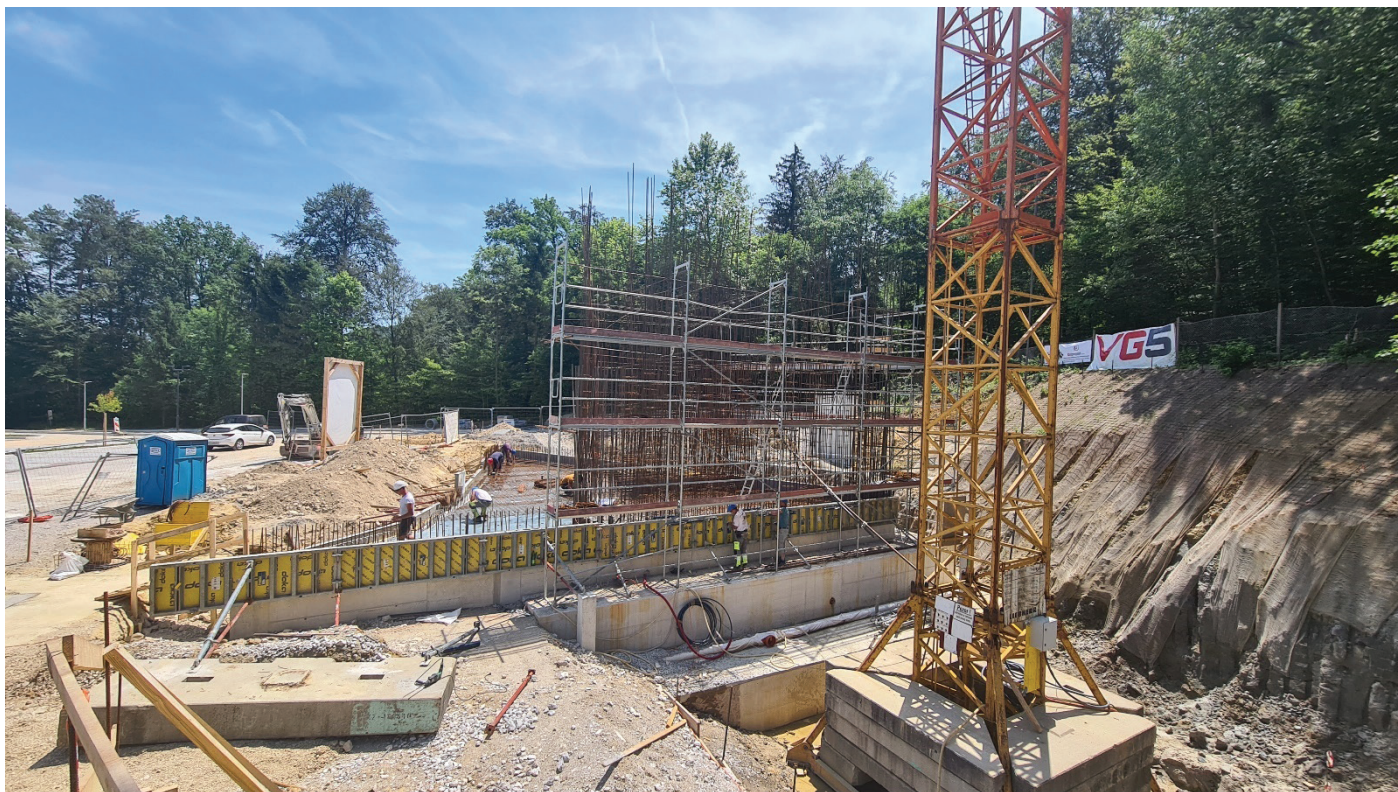
Slika 5. Opaženje in armiranje temeljne plošče pritličja (16. 6. 2022).
