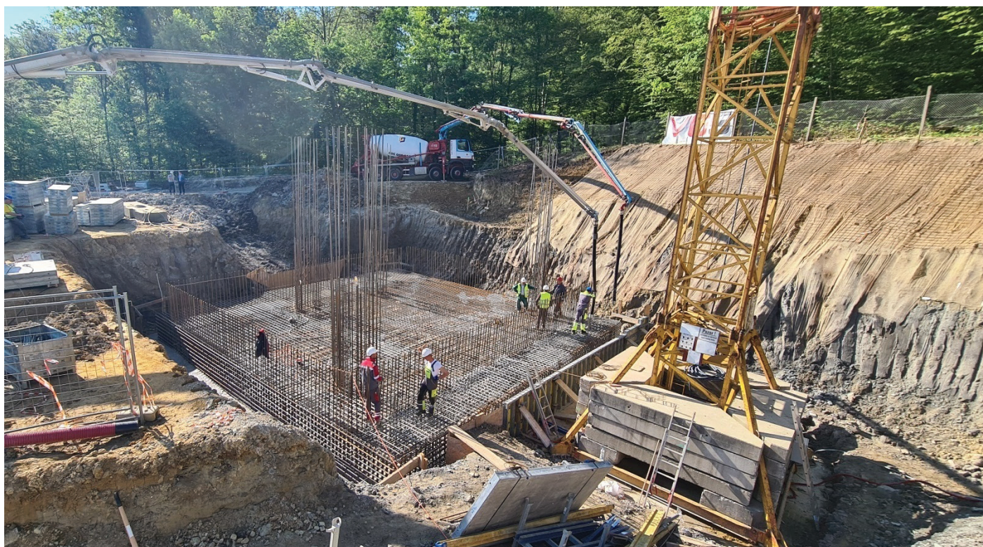
Slika 4. Betoniranje 1. faze masivnega plitvega temelja (12. 5. 2022).
