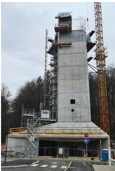
Slike 8, 9, 10. Izdelanih je 9 segmentov stebra, h = 34,65 m (10. 1. 2023).
