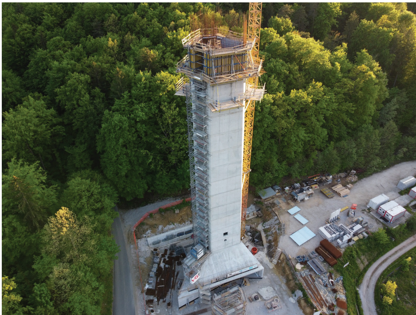
Slika 1. Trenutno stanje na gradbišču. Izvedenih je 15 od 25 segmentov stebra, h = 57,75 m (9. 5. 2023).
