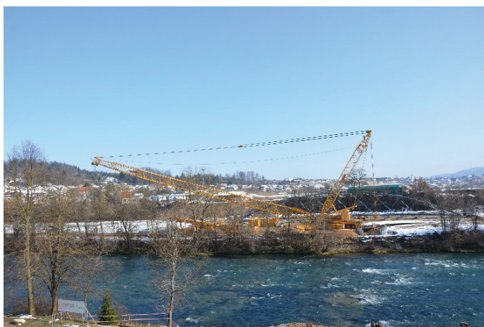
Slika 6 do 8. Sestavljanje dvigala za premik primarne nosilne konstrukcije glavnega razpona, januar 2023 (Foto: Arhiv Občine Medvode).
