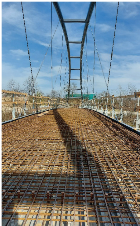
Slika 14. Vgradnja armature v prekladni konstrukciji, marec 2023 (Foto: Arhiv Občine Medvode).
