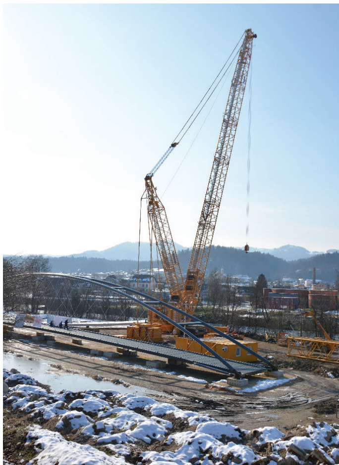
Slika 6 do 8. Sestavljanje dvigala za premik primarne nosilne konstrukcije glavnega razpona, januar 2023 (Foto: Arhiv Občine Medvode).
