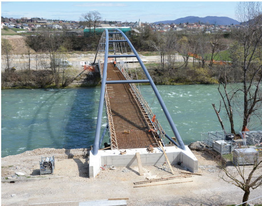
Slika 15. Zaključeno betoniranje desnega opornika, marec 2023 (Foto: Arhiv Občine Medvode).
