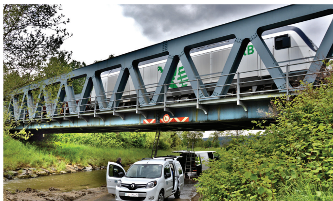
Slika 1. Stranski pogled na jekleni železniški most.
