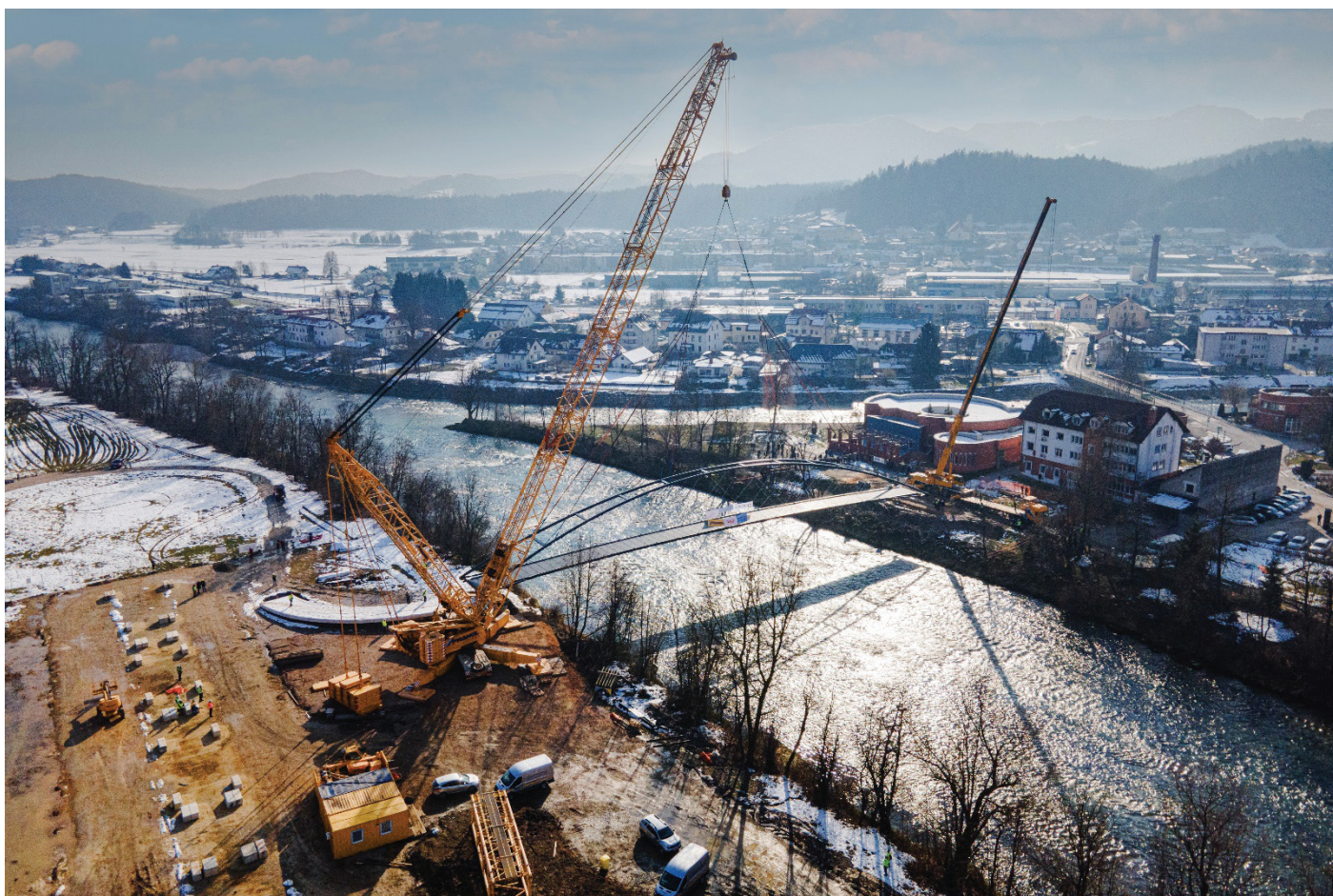
Slika 1. Premik primarne nosilne konstrukcije glavnega razpona, februar 2023 (Foto: prostovoljci ESC in Medvode).
