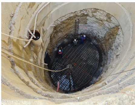
Slika 4 do 6. Izkop in vgradnja armature v vodnjak 1, marec-april 2022 (foto: Danilo Malnar).
