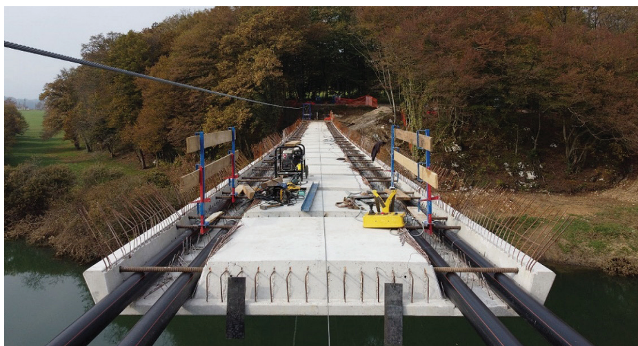
Slika 14. Vgradnja prefabriciranih betonskih segmentov, oktober 2022 (foto: Ponting, d. o. o.).
