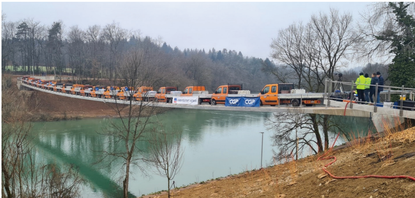
Slika 16. Obremenilna preizkušnja, marec 2023 (foto: Pipenbaher inženirji, d. o. o.).
