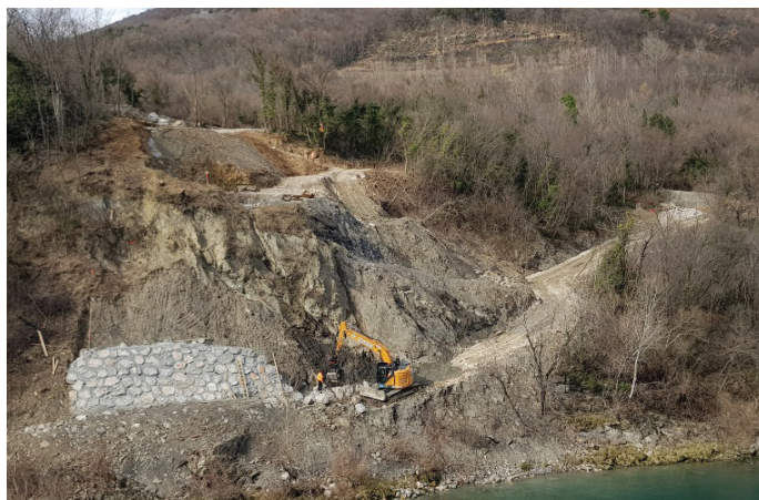
Slika 4. Izdelava obrežne zaščite pred vplivom visokih vod na desni brežini.
