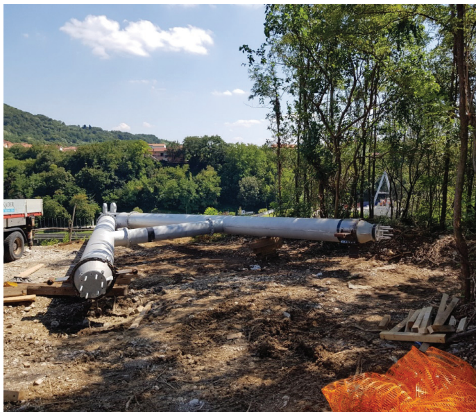
Slika 10. Sestavljeni desni pylon z montiranim ležiščem pred montažo na sidrišče.
