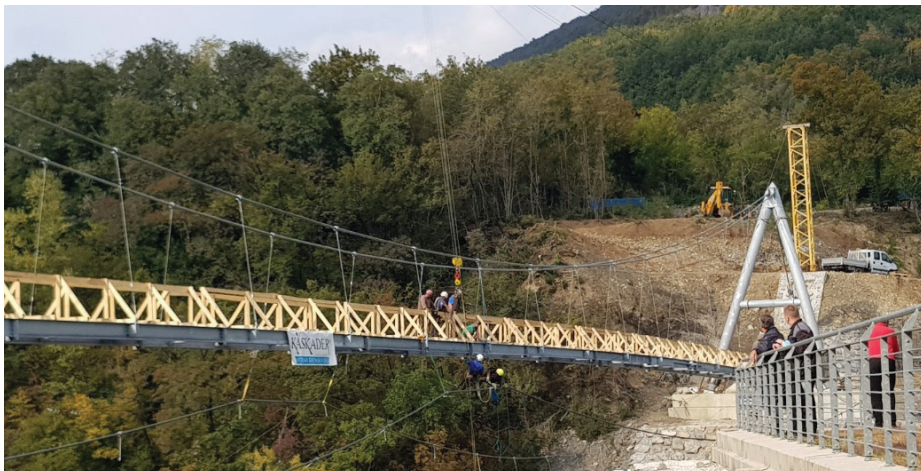
Slika 14. Spajanje posameznih segmentov pohodne konstrukcije in pritrdjevanje zavetrovalnih vrvi.
