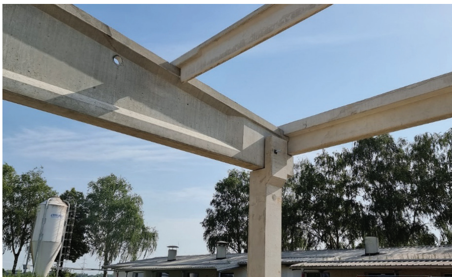
Slika 7. Naleganje robnega in sekundarnega nosilca na primarni dvokapni nosilec. Primarni nosilec nalega na steber.
