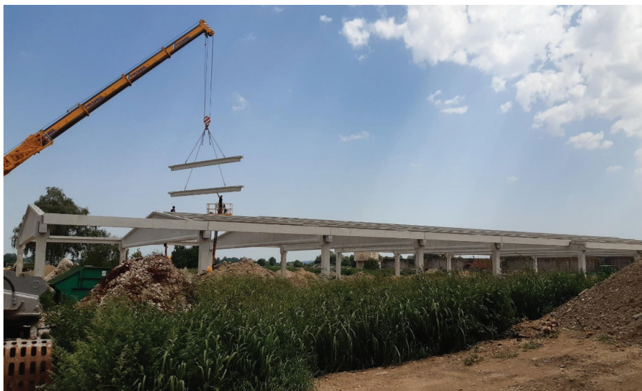
Slika 6. Montaža sekundarnih nosilcev na primarne dvokapne nosilce.
