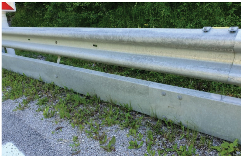
Slika 5. Pravilna izvedba ML (prikaz odbojnika oziroma ščita je simboličen).
