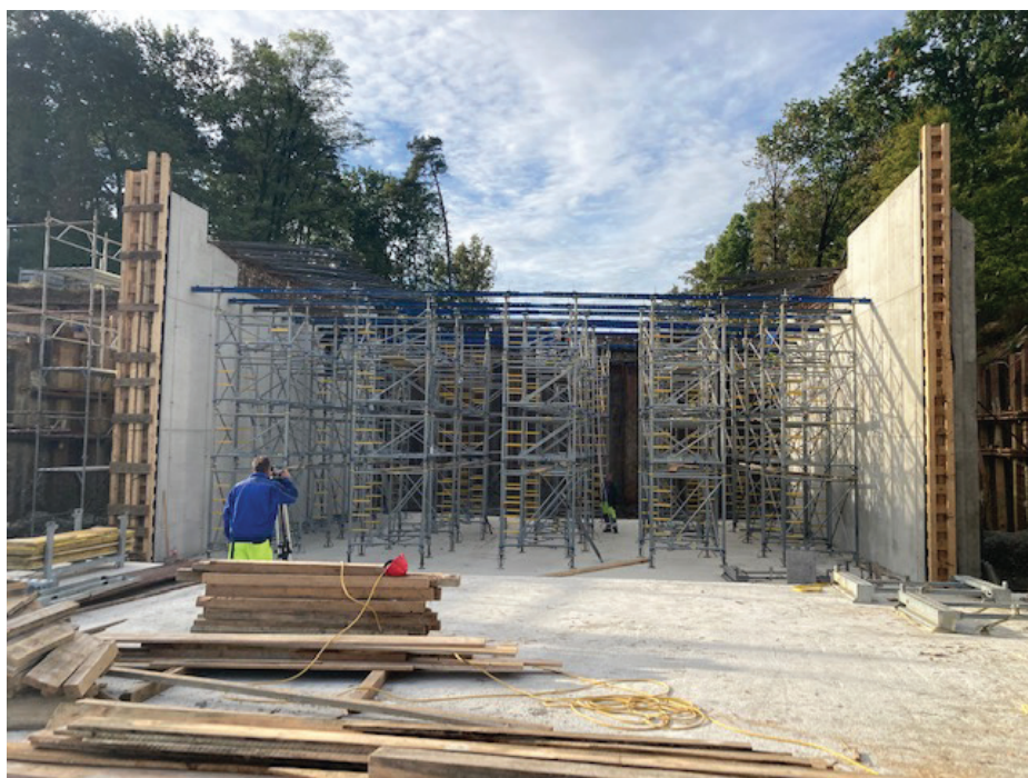
Slika 3. Postavljanje podporne konstrukcije za prekladno konstrukcijo (oktober 2021).
