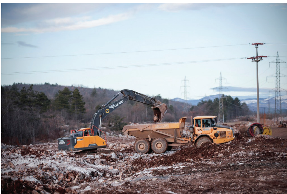
Slika 4. Izkop na območju odprtega dela trase med Divačo in Lokvijo.
