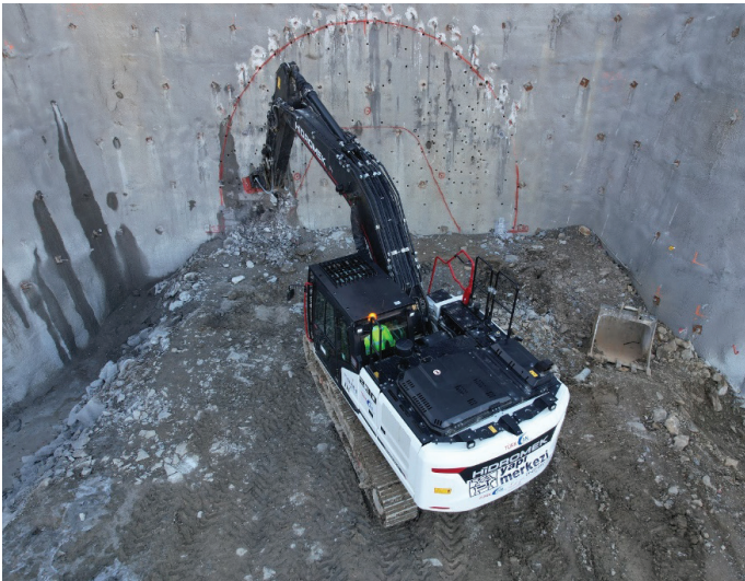
Slika 11. Začetek gradnje predora Škofije (T8) s severne strani v decembru 2021.
