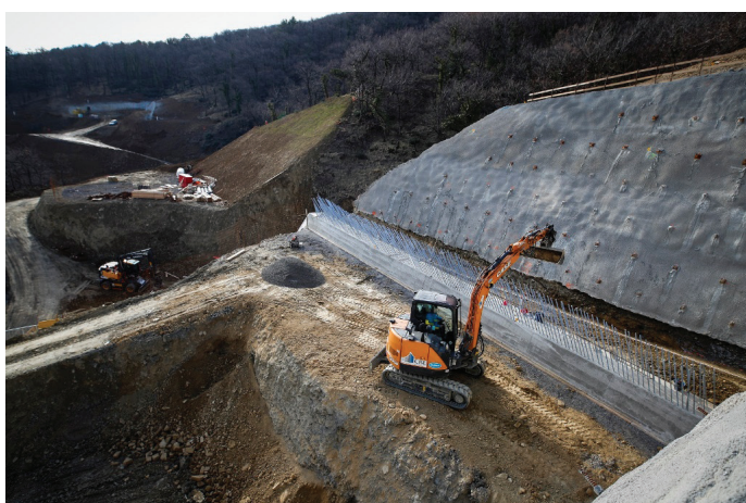
Slika 9. Gradnja dostopnih cest in območij predorskih portalo v med predoroma Mlinarji (T7) in Osp (T5-6).
