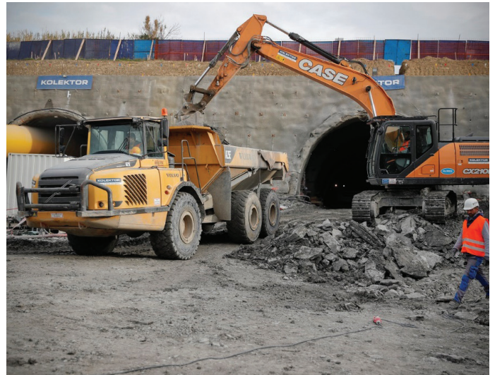
Slika 12. Gradbišče predora Škofije (T8) z južne strani.
