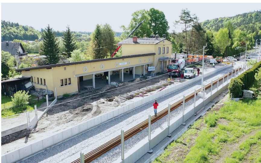
Slika 6 • Prenova železniškega postajališča Otoče. Foto: arhiv Direkcije RS za infrastrukturo.
