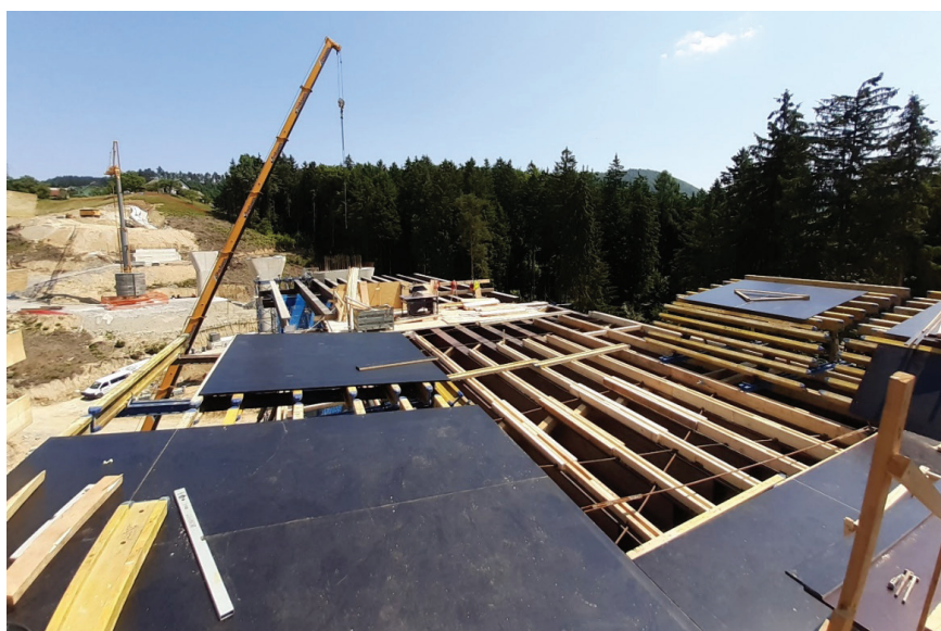
Slika 2 • Montaža opaža prvega polja prekladne konstrukcije nadvoza 4-03.
