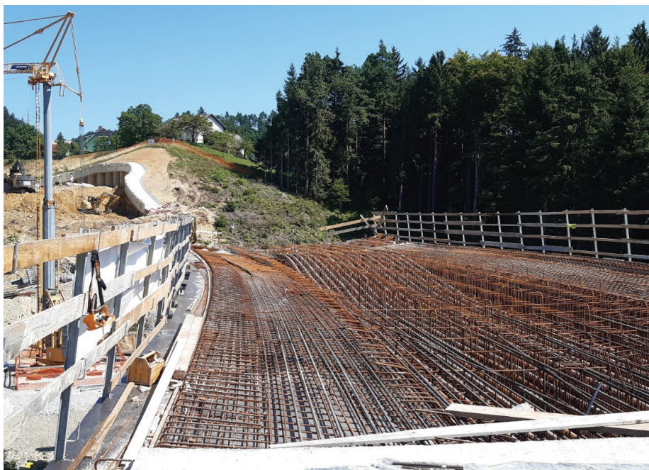
Slika 3 • Armatura četrtega polja prekladne konstrukcije nadvoza 4-03.
