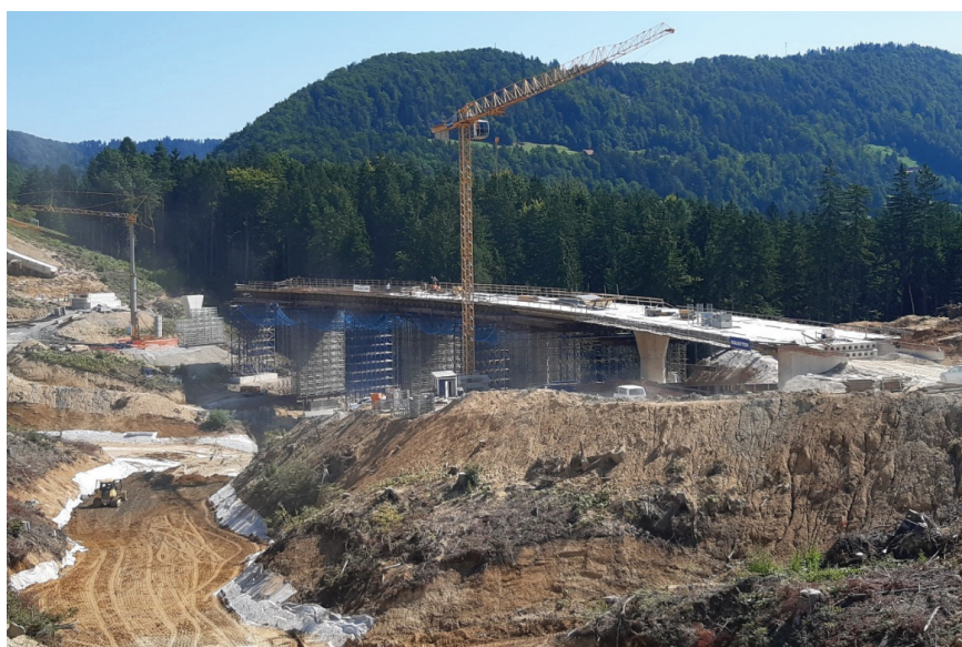
Slika 1 • Nadvoz 4-03 preko hitre ceste v priključku Gaberke.
