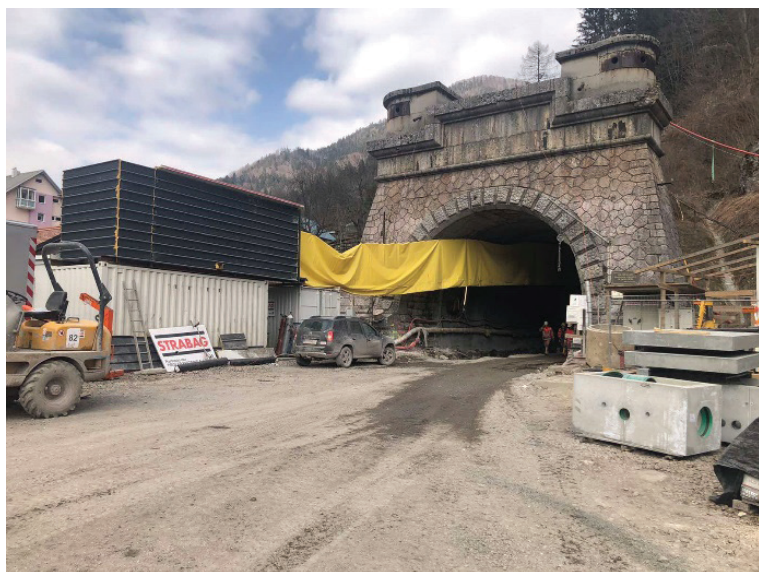
Slika 1 • Pogled na južni portal železniškega predora Karavanke na slovenski strani. Južni portal bo restavriran. Foto: arhiv Direkcije RS za infrastrukturo
