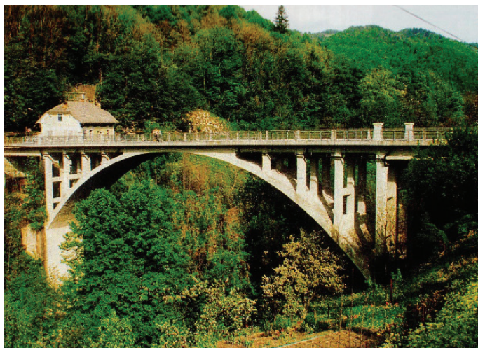
Slika 9 • Armiranobetonski cestni most čez Idrjico pri Mostu na Soči. Napredek pri razvoju oblike v primerjavi s kamnitimi mostovi je viden. Foto: Boždan Kladnik
