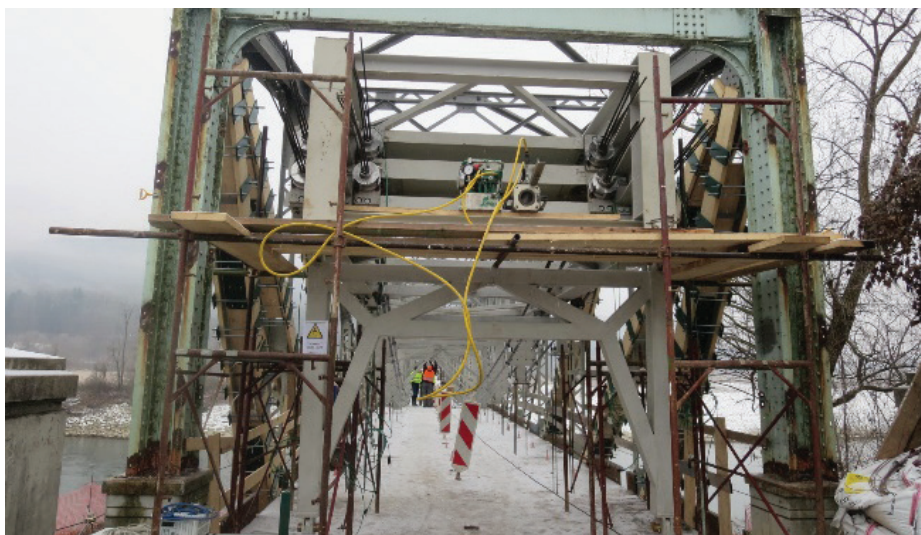
Slika 5 • Podpiranje podporne konstrukcije in sidranje kablov.
