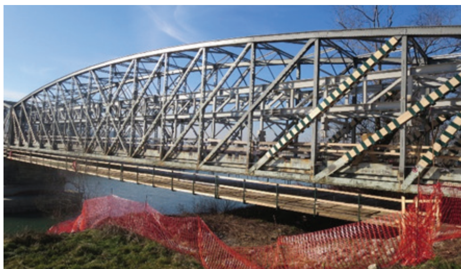
Slika 3 • Samonosilna začasna jeklena podpora konstrukcija znotraj obstoječe konstrukcije.
