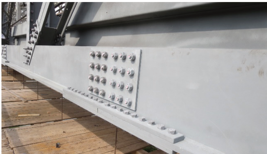
Slika 7 • Spodnji pas po zamenjavi.
