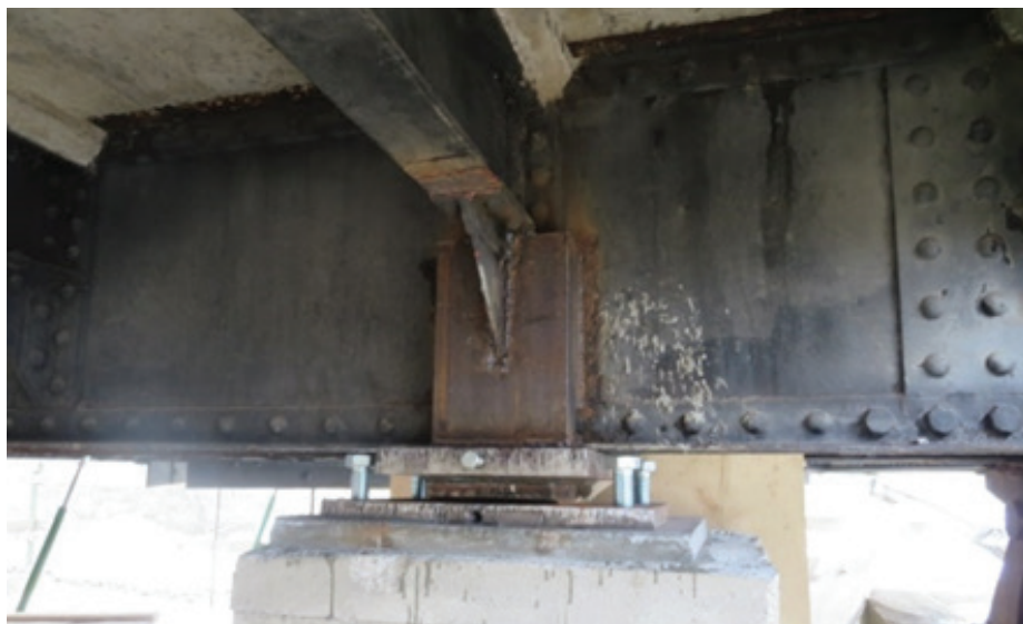
Slika 12 • Ojačitev krajnega prečnika in dodatno podpiranje.
