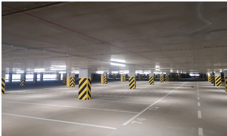
Slika 2 • Notranjost dokončane garažne hiše. Foto: arhiv GIC GRADNJE, d.o.o.
