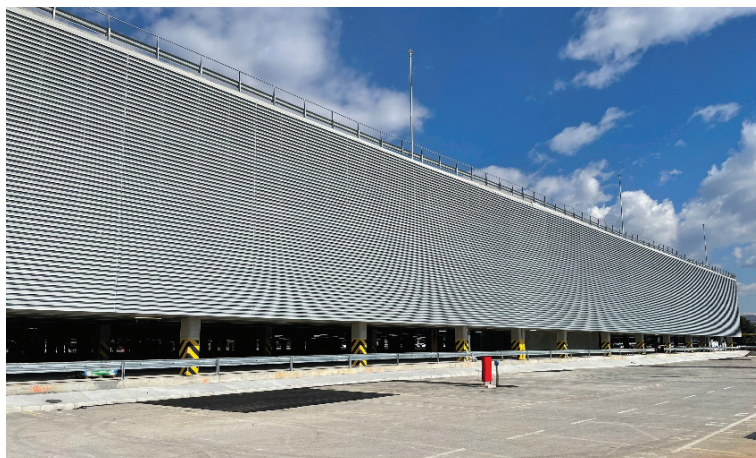
Slika 3 • Pogled na unikatno fasado izvedeno iz aluminijastih profilov, proizvedenih posebej v ta namen. Foto: arhiv GIC GRADNJE, d.o.o.
