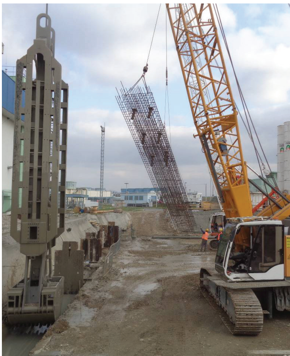
Slika 5 • Izkop za diafragma in vgradnja armaturnega koša.
