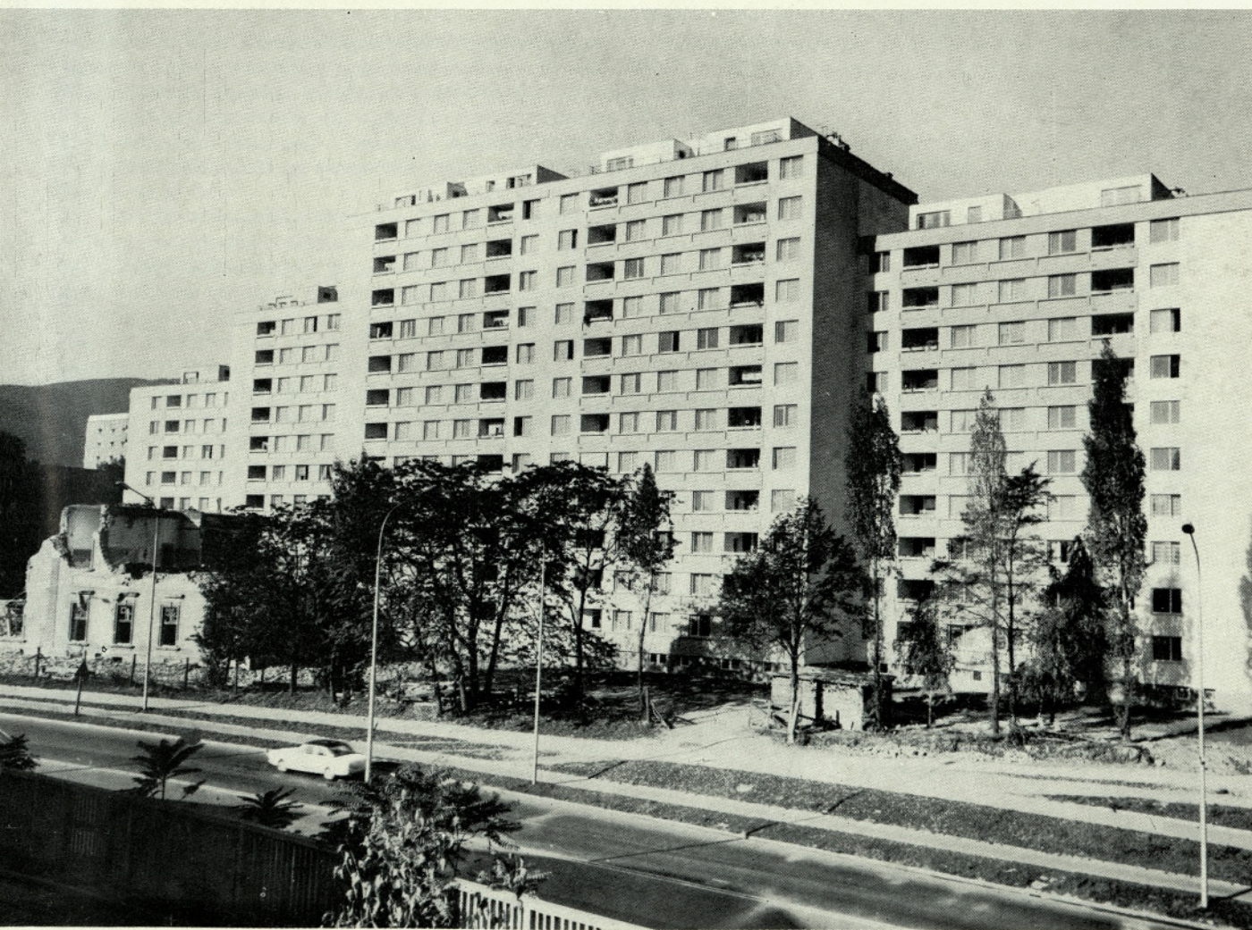
PVG »STAVBAR« MARIBOR: 218-stanovanjski blok ob Titovi cesti v Mariboru
