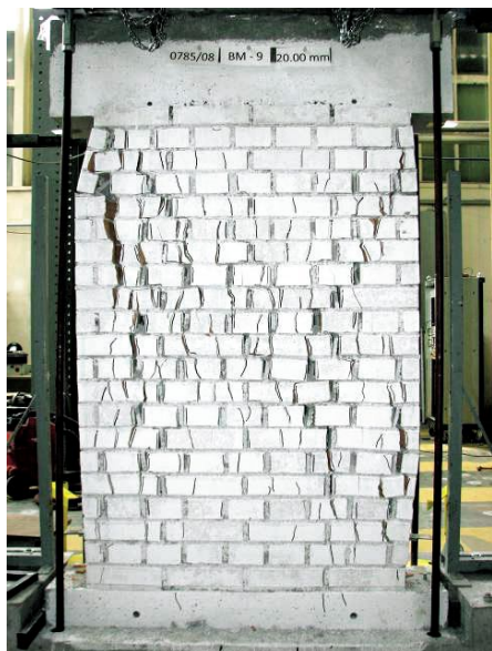
Slika 11 • Referenčni, neutrjeni zid pred porušitvijo
