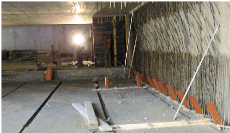
Slika 4 • Armatura stika – zadrge med polnilno steno in diafragmo
