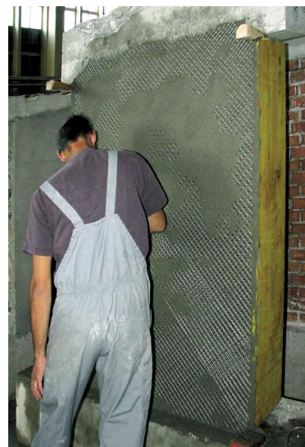
Slika 6 • Diagonalno postavljena GFRP-mreža in nanašanje cementne malte
