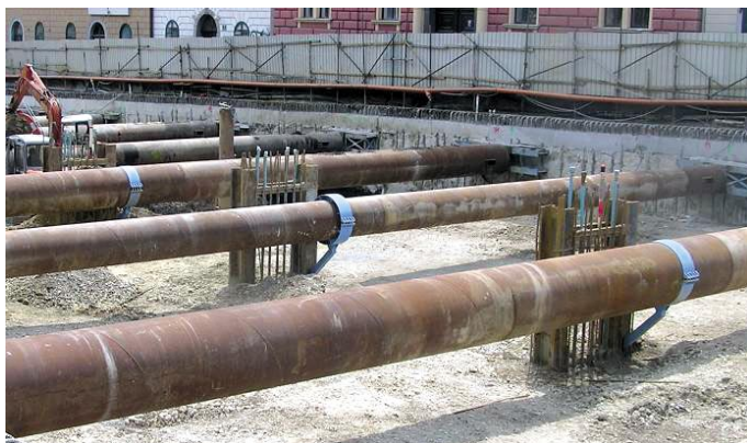
Slika 6 • Razporne cevi in arheološka izkopavanja
