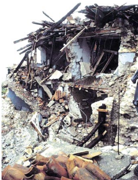
Slika 21 • Črna gora, 1979: porušitev kamnite hiše z nepovezanim zidovjem
