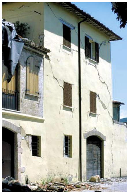
Slika 25 • Umbrija, 1997: tipične poškodbe kamnite hiše z nepovezanim zidovjem
