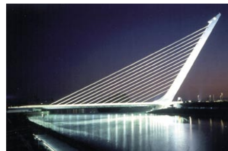
Slika 3 • Santiago Calatrava Alamillo Bridge (1992), Seville, Španija
