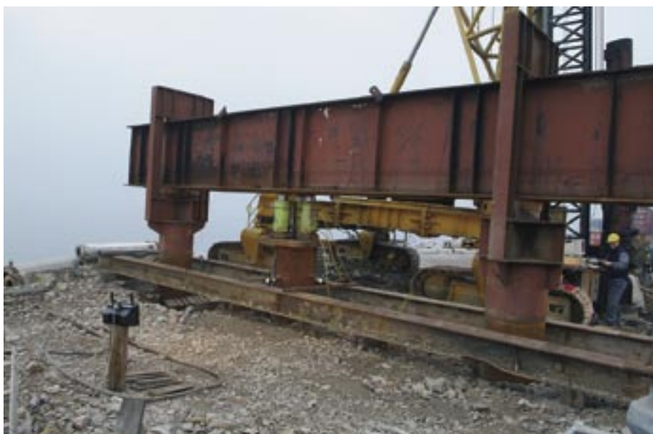
Slika 2 • Statični obremenilni preizkus pilota P2 za gradnjo obale veza 7c (foto: B.Pulko)
