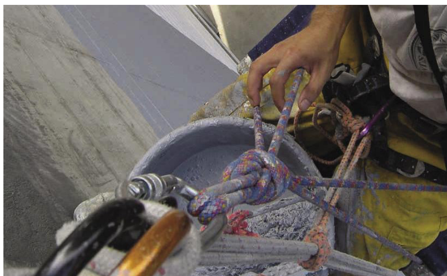
Slika 10 • Nepravilnost – vpenjanje delovnega sedeža v napravo za spuščanje
