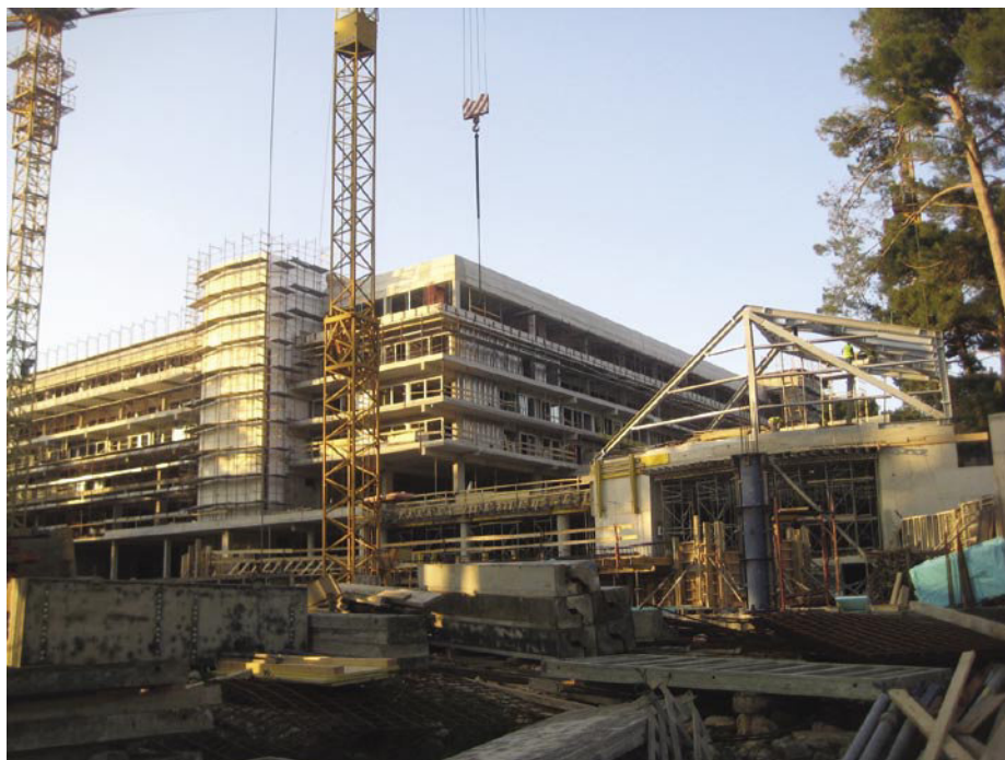
Gradbišče hotela Bellvue (Foto: Miro Benčina)
