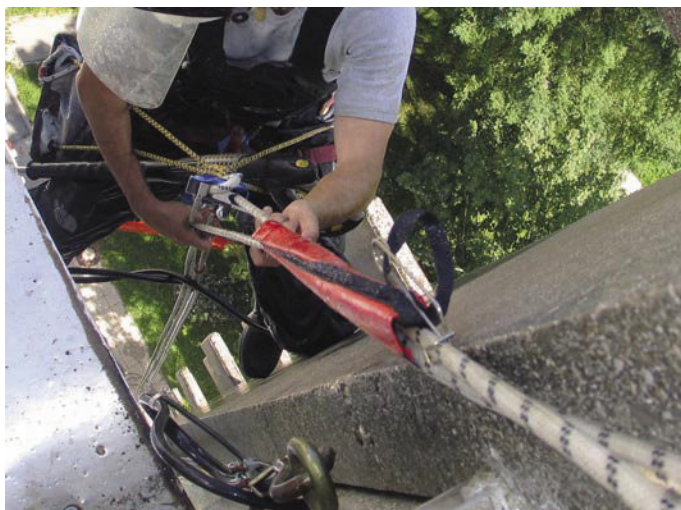
Slika 8 • Nepravilnost – uporaba športne opreme, Petzl GRI-GRI
