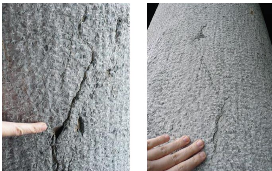
Slika 6 • Izpiranje iz razpok – levo: izpiranje v večjem obsegu; desno: izpiranje v manjšem obsegu
