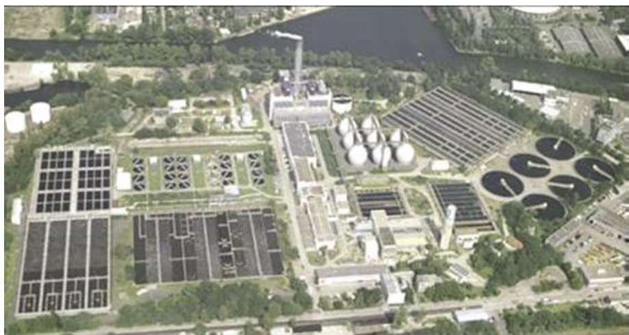
Slika 1 • Čistilna naprava RUHLEBEN v Berlinu čisti 1,6 mio. PE, 2,86 m 3 /s sušnega in 6,9 m 3 /s padavinskega dotoka. Že leta 1985 so opustili 8 anaerobnih reaktorjev za proizvodnjo bioplina (gnilišč) s po 6.500 m 3 , skupaj 52.000 m 3 prostornine. Sedaj so uporabljeni za izravnalni rezervoar blata pred njegovim sežigom.
