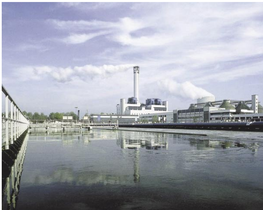
Slika 2 • Sežigalnica blata z 8 opuščeni gnilišči za upravno zgradbo čistilne naprave. Poleg blata iz čistilne naprave sežigajo še blato čistilne naprave za pitno vodo.
