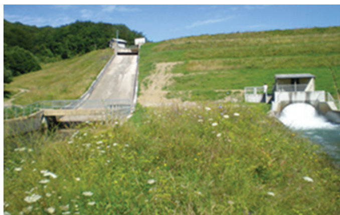
Slika 10 • Preliv in izpust Klivnika.
