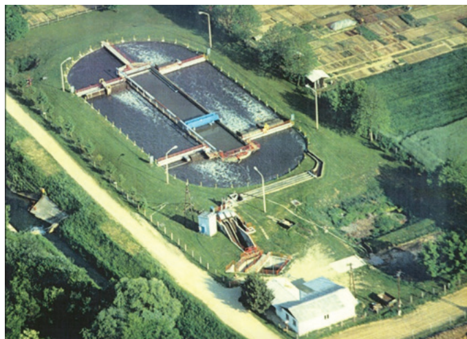
Slika 2 • Čistična naprava Murka Sobota za 30.000 PE, 1970 za nitrifikacijo in možno denitrifikacijo (Rismal, 1973)
