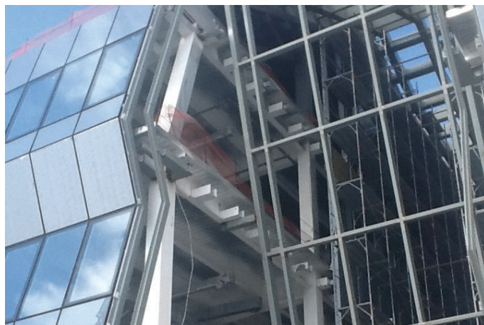
Slika 5 • Konstrukcija in fasadni pas internacionalnega objekta.
