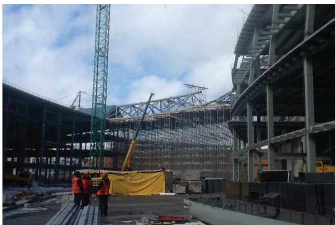
Slika 8 • Montaža enega od strešnih mostov.
