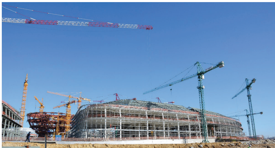
Slika 3 • Gradbišče kompleksa C3.
