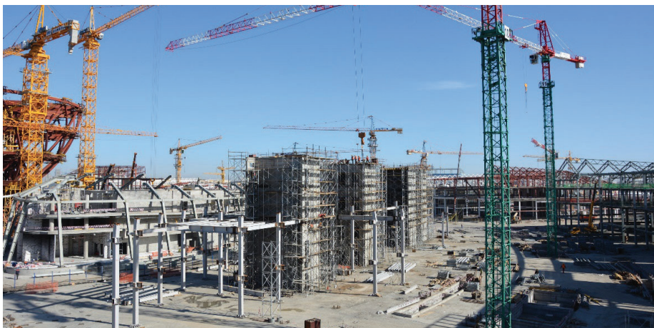
Slika 10 • Gradnja tematskega paviljona.
