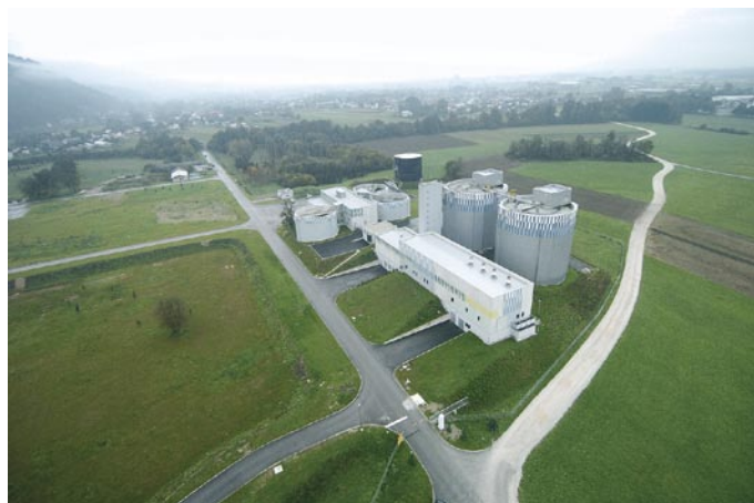
Slika 15 • Negospodarna gnilišča na ljubljanski čistilni napravi s pripadajočimi objekti za sušenje blata z lastnim in zemeljskim plinom. Zaradi prevelikega ostanka organskih snovi v posušenem blatu pa ostaja problem blata še naprej nerešen
