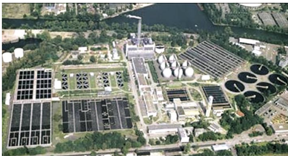
Slika 16 • Pogled na čistilno napravo Ruhleben v Berlinu za 1,6 milijona PE, kjer so, enako kot v Celju, že pred 20 leti opustili 8 gnilišč z 52.000 m 3 za proizvodnjo bioplina in zgradili sežigalnico za direkten sežig dehidriranega blata
