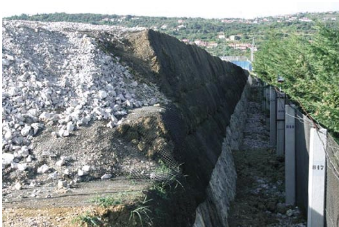
Slika 42 • Armirana (levo) in s kamnom v betonu obložena (desno) brežina nasipa ceste
