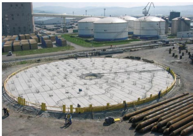
Slika 46 • Temeljna plošča rezervoarja R-09 med gradnjo; v ozadju rezervoarji za rastlinska olja (fotografija: Gorazd Sirmiša)
