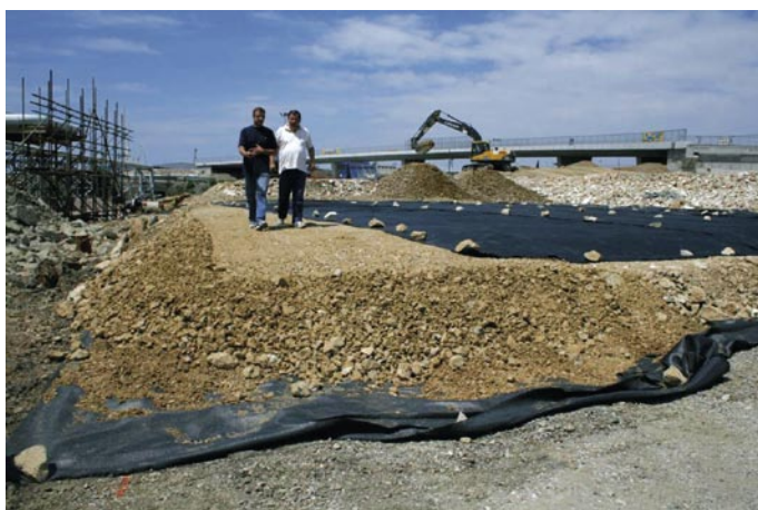
Slika 43 • Armiranje vznožja nasipa, kjer je ta grajen neposredno na mehka tla koprške Bonifike ob obstoječem platoju Luke
