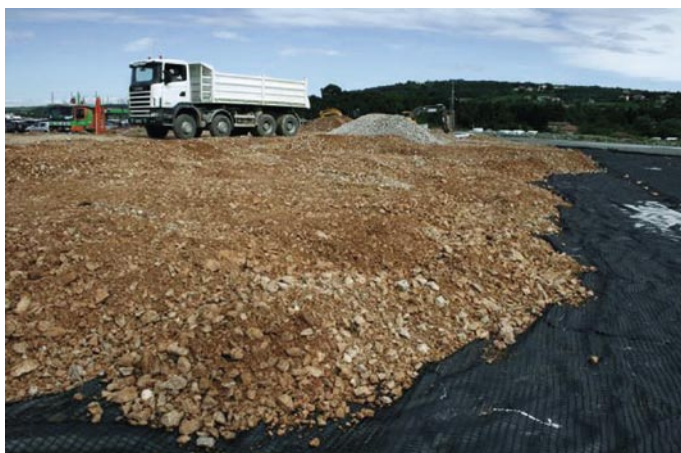
Slika 40 • Prekrivanje kanala 8-8 med izvedbo
