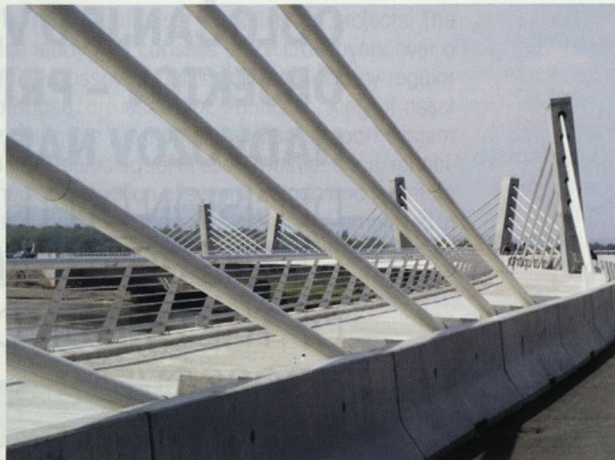
Slika 13 • »Extrados« kabli med stezo za pešce in kolesarje ter voziščem
