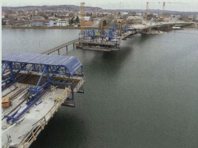
Slika 11 • Gradnja prekladne konstrukcije
