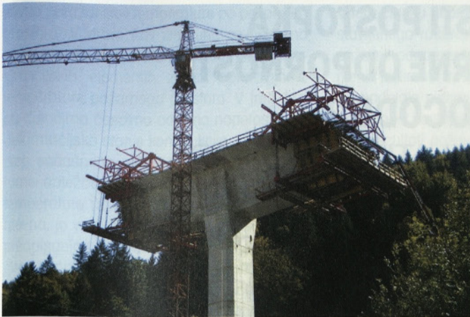
Slika 7 • Prostokonzolna gradnja prekladne konstrukcije
