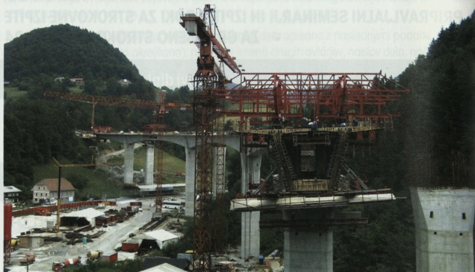
Slika 1 • Pogled na gradnjo viadukta Petelinjek z ljubljanske strani
