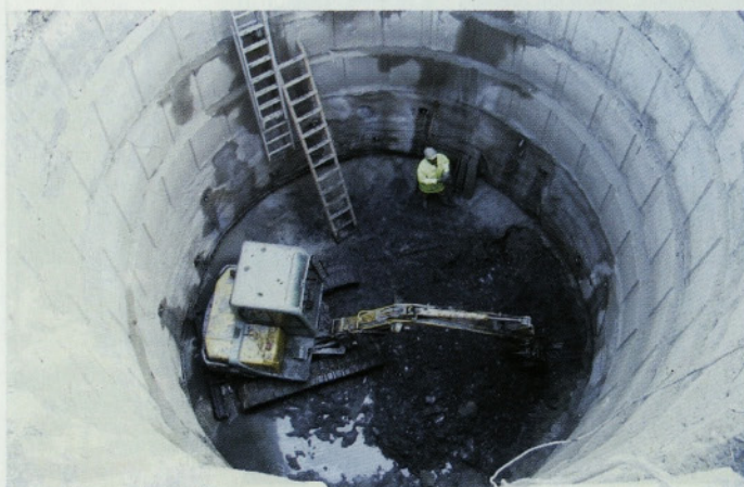
Slika 6 • Izvedba vodnjaka vmesne podpore
