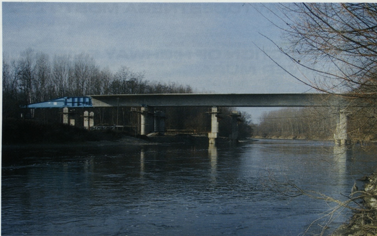
Slika 1: Prva polovica mostu po prehodu reke Mure
