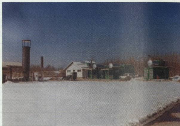
Slika 9: Pridobivanje 25.000 m³ bioplina na dan z instalirano močjo plinskih motorjev 2,2MW na Ljubljanski deponiji smeti (februar 2003)
