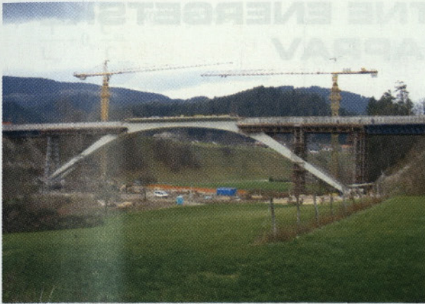
Slika 37: Z izvedbo voziščne plošče škatlastega prereza, levo in desno od loka, je bila armiranobetonska konstrukcija viadukta končana.
