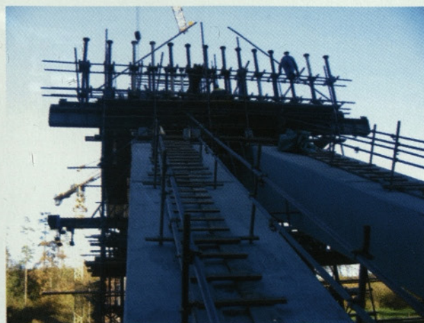
Slika 33: Montaža stolpa podpornega odra konstrukcije nad ločno konstrukcijo
