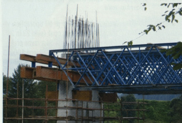
Slika 27: Detalj naleganja H33 nosilcev na vmesno podporo
