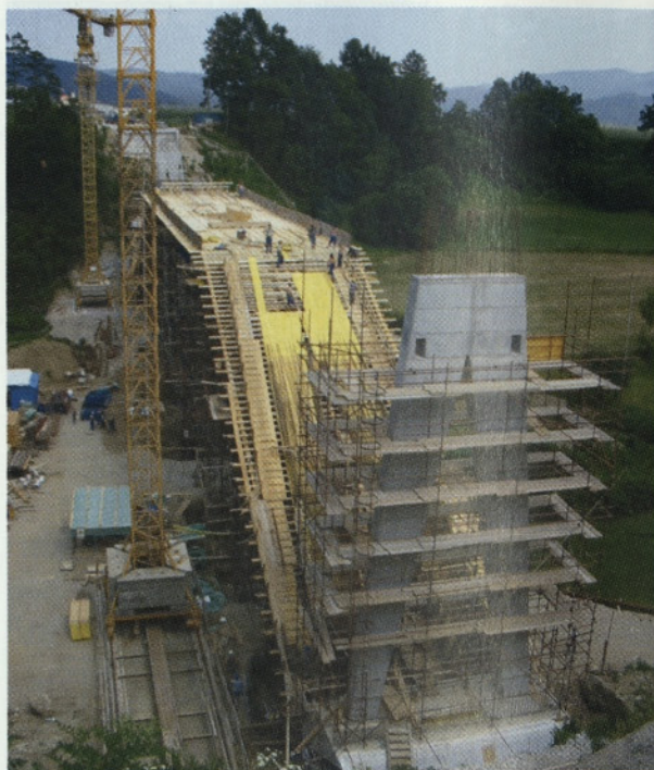
Slika 16: Podporni oder loka v fazi montaže, opaž in polaganje armature v spodnjem delu loka
