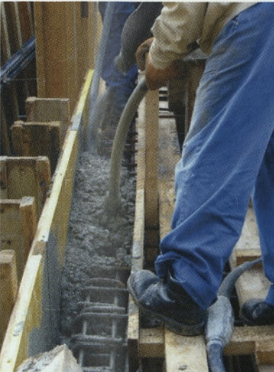
Slika 20: Betoniranje sten škatlastega prereza loka
