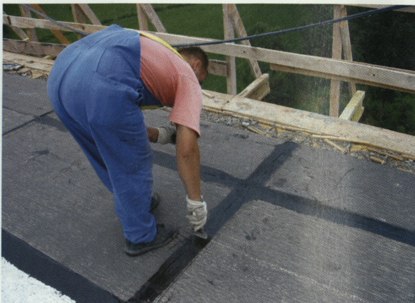
Slika 35: Izvedba hidroizolacije "Servidek/Servipak" pod hodniki na centralnem delu loka na sveži beton
