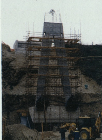
Slika 24: Podporni stebor ravne prekladne konstrukcije na zahodni strani
