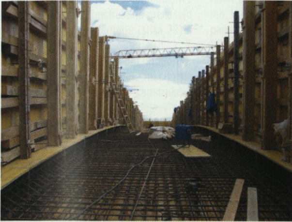
Slika 19: Armatura in opaž loka v zaključni fazi; betoniranje sten je bilo izvedeno skupaj s spodnjo ploščo
