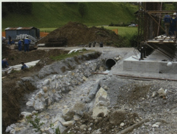
Slika 11: Zaščita temeljev podpornega odra s kamnito zložbo na brežinah Radeljskega potoka
