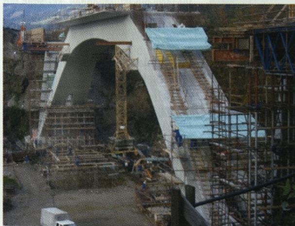
Slika 32: Pred prihajajočo zimo so se dela izvajala tudi v slabem vremenu pod začasnimi nadstrešnicami
