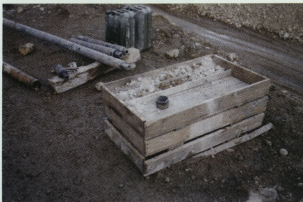
Slika 5: Dodatno raziskovanje temeljnih tal z izvedbo sondažnih vrtin
