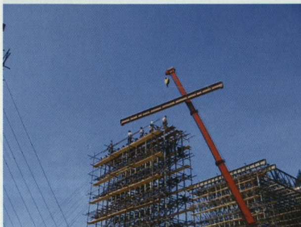
Slika 14: Montaža I nosilcev teže 46 kN na vrh stolpov podpornega odra loka kot ležišč za nosilce H33 in Sisak
