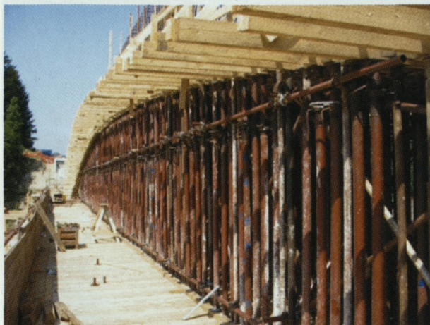
Slika 15: Podpiranje centralnega dela loka
