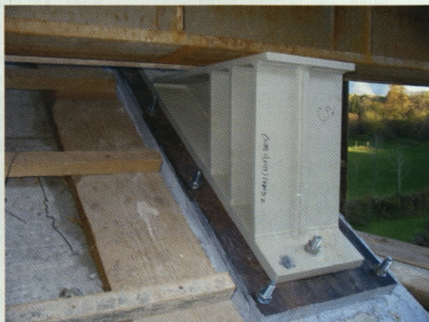
Slika 31: Detalj sidranja stolpov podpornega odra na ločni konstrukciji
