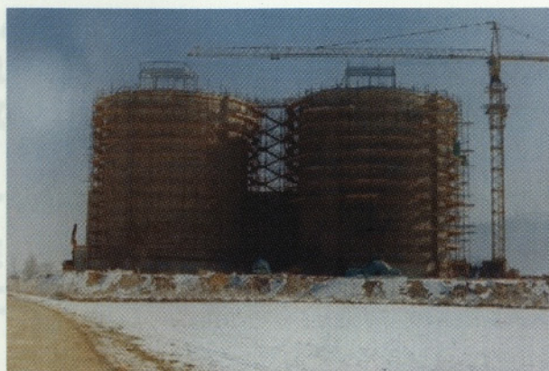
Slika 7: Gradnja tehnično – ekonomsko nepotrebnih gnilišč na ČN Ljubljana, februar 2003.
