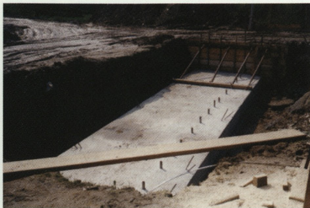
Slika 10: Temelj podpornega odra dim. 11 x 3 x 0,5 m za ločno konstrukcijo
