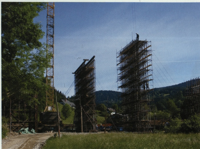
Slika 12: Montaža stolpov podpornega odra ločne konstrukcije
