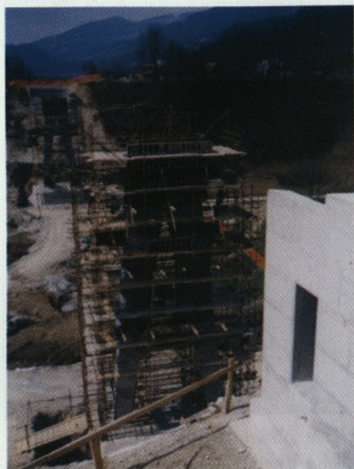
Slika 23: Gradnja podpornih stebrov ravne prekladne konstrukcije
