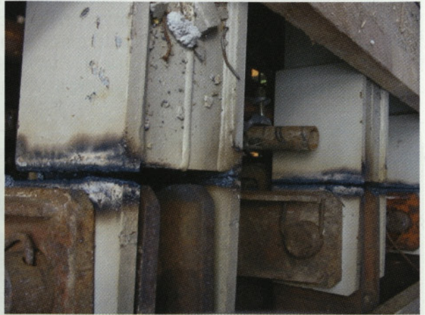
Slika 21: Ker je bila podporna konstrukcija loka vpeta v temelje, je bila sprostitev opaža izvedena z rezanjem razpornih elementov
