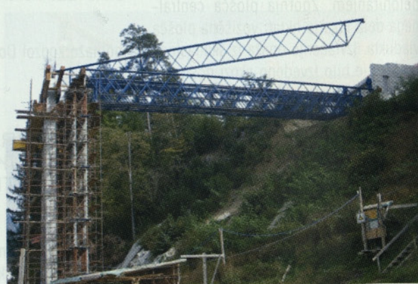
Slika 28: Podporni oder ravne prekladne konstrukcije na vzhodni strani
