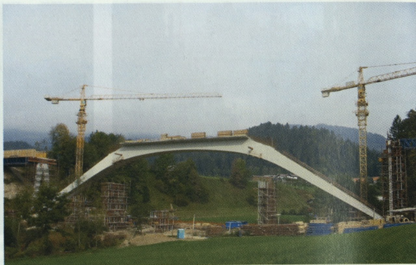
Slika 25: Podporni oder ravne prekladne konstrukcije izven območja loka
