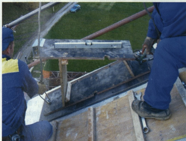
Slika 30: Priprava ležišča stolpa podpornega odra na ločni konstrukciji
