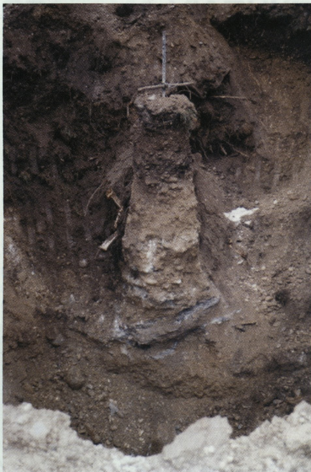
Slika 4: Odkop poskusnega jet-grouting kola
