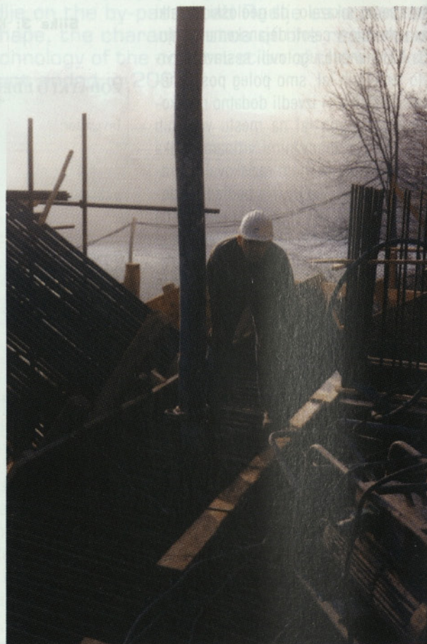
Slika 7: Betoniranje temelja vmesnega opornika skozi odprtine, izrezane v armaturi
