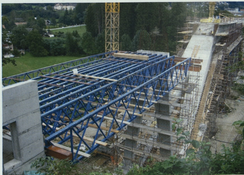
Slika 26: Podporni oder ravne prekladne konstrukcije na zahodni strani
