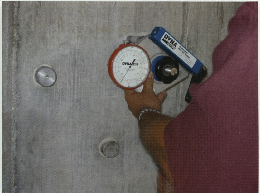
Slika 22: Kontrola oprijema pred izvedbo zaščitnega premaza betonskih površin loka
