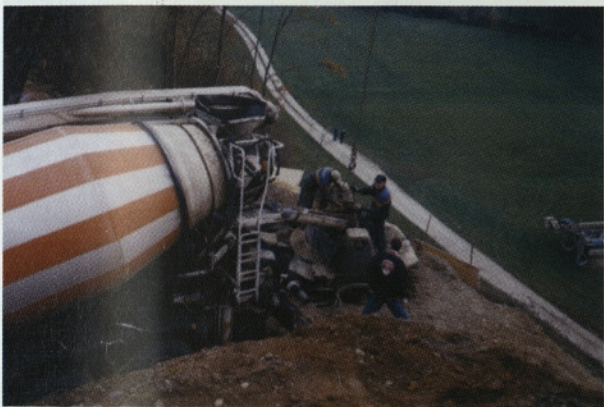
Slika 9: Izvedba globokega temeljenja krajnih opornikov s piloti Benotto premera 150 cm
