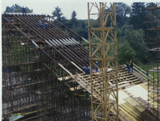
Slika 13: Montaža stolpov in nosilcev podpornega odra centralnega dela loka
