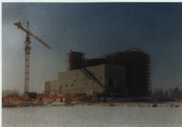
Slika 8: Gradnja tehnično – ekonomsko neupravičene strojnice in gnilišč na ČN Ljubljana, februar 2003
