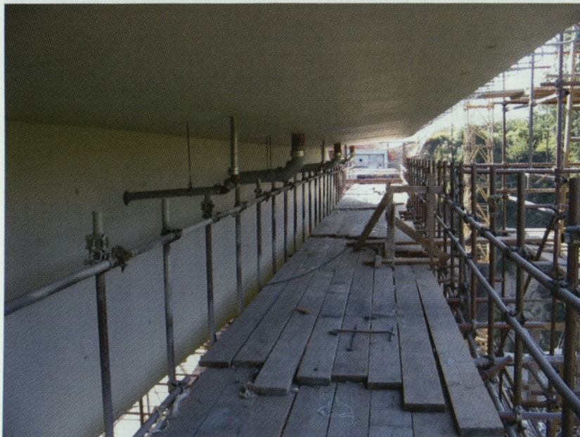
Slika 36: Takoj po razopaženju ločne konstrukcije je bil izveden zaščitni premaz in odvodnjavanje tega dela objekta
