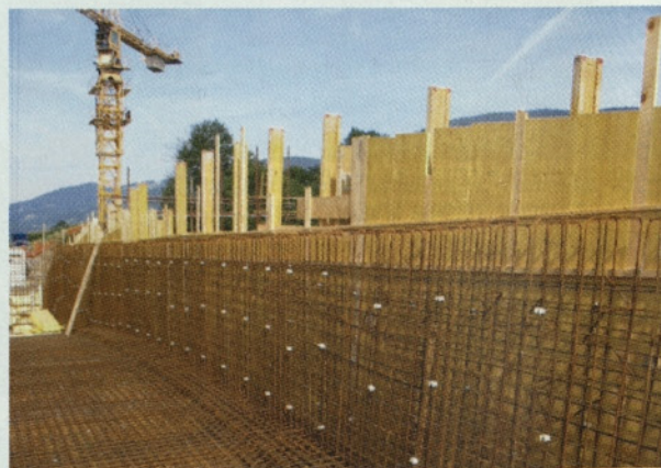
Slika 18: Armatura spodnje plošče in sten loka
