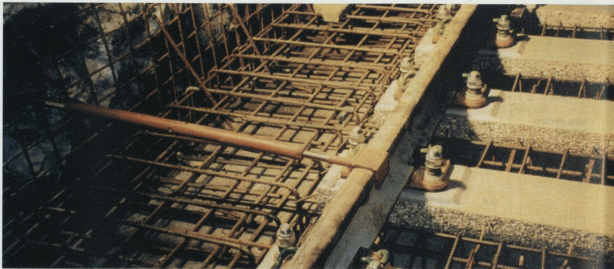
Slika 7: Fiksiranje osi tira s horizontalnim sidrom [Pandrol, 1998]
