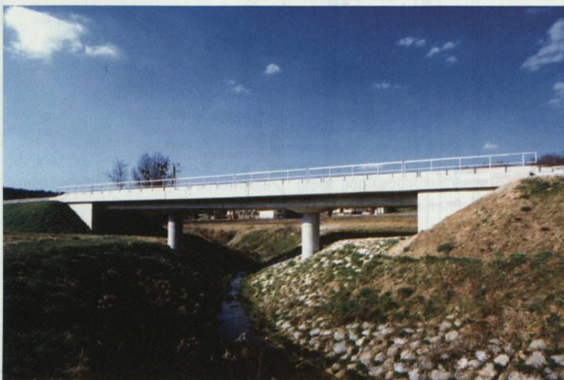
Slika 6: Najdaljši železniški most prek Peskovskega potoka
