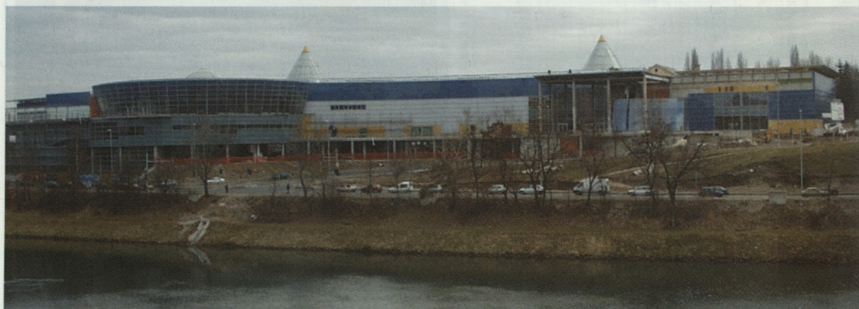
Slika 7: Objekt po končanju gradbenih del
