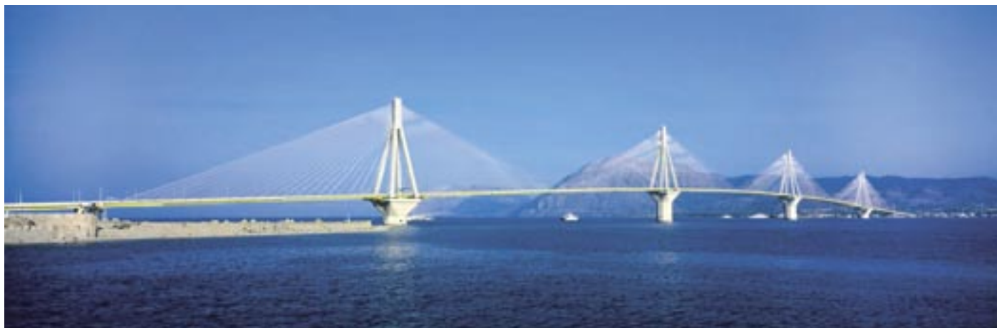
Slika 4 • Most Rion-Antirion pri Patrasu v Grčiji (l. 2004). Dolžina mostu 2250 m, trije glavni razponi po 560 m, štirje nosilni piloti višine 160 m nad morjem. Foto F. Vigouroux
