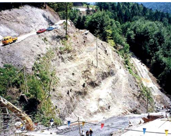
Slika 2 • Izvedbeno zahteven visoki pobočni nasip Orehovica na izstopu iz predora V Zideh ob začetku in po končani gradnji
