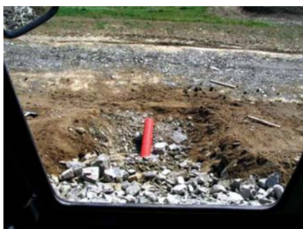
Slika 18 • Pogled na jarek za vgradnjo merilne (inklinacijske) cevi in detekcija cevi pod površino med merilnim prehodom na zaslonu BCM 05
