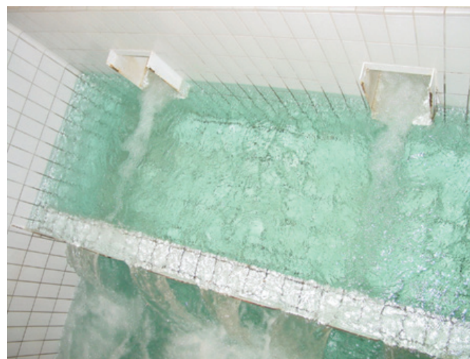
Slika 22 • Obrežni filtrat na iztoku iz lamelnih usedalnikov.
